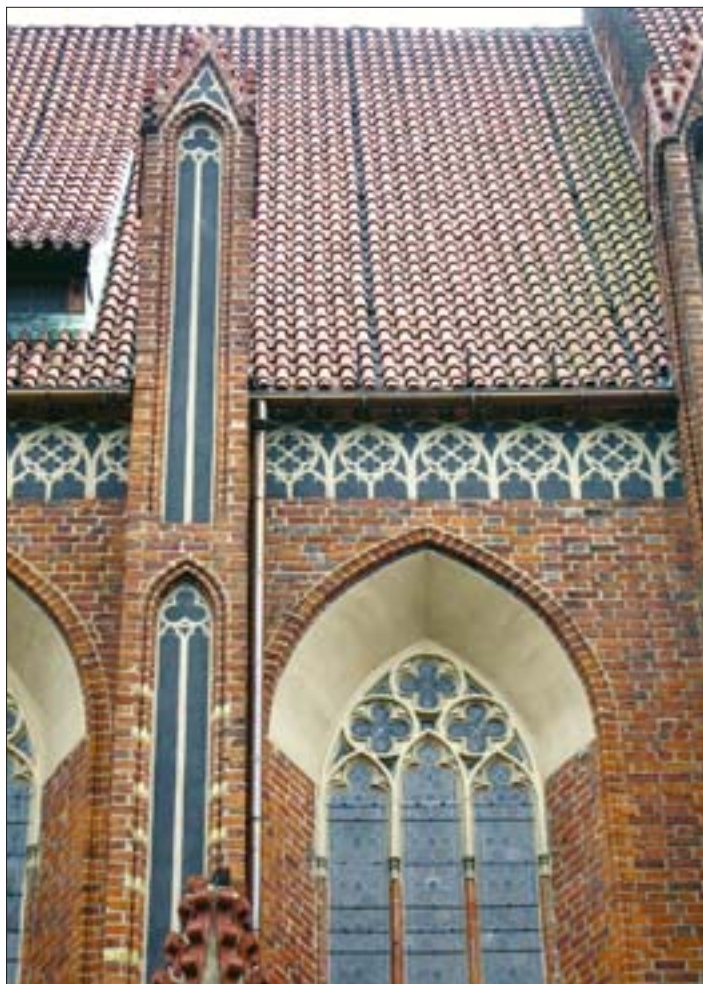
19. Toruń, kościół p.w. św. Jakuba, dekoracja maswerkowa gzymsu i blend na trzonach skarp prezbiterium, widok od północy.
