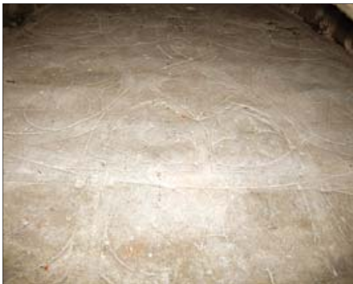
12. Blenda nr 2, zbliżenie dolnej części strefy rozetowej, widok od dołu.
