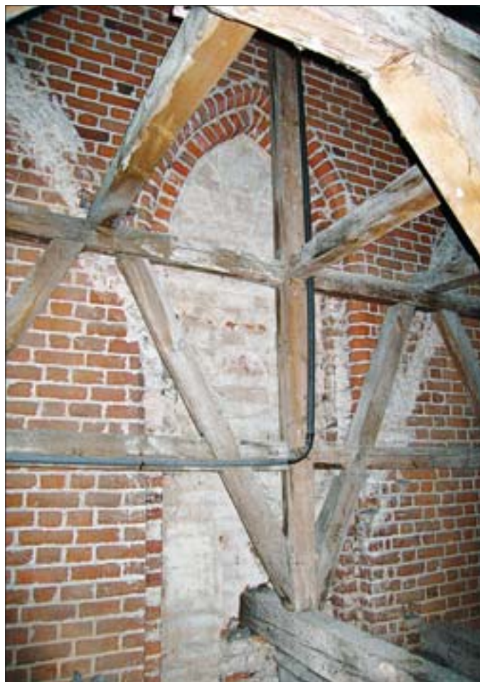
10. Blenda nr 2, widok ogólny. 10. Blind window no. 2, general view.
