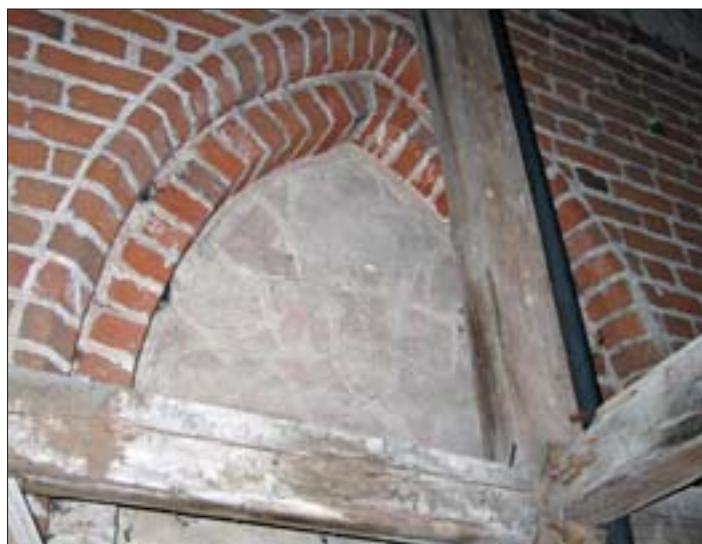
5. Blenda nr 2, zbliżenie strefy rozetowej z kompozycją w układzie promieniującym. 5. Blind window no. 2, close-up of the rosette with a radial composition.
