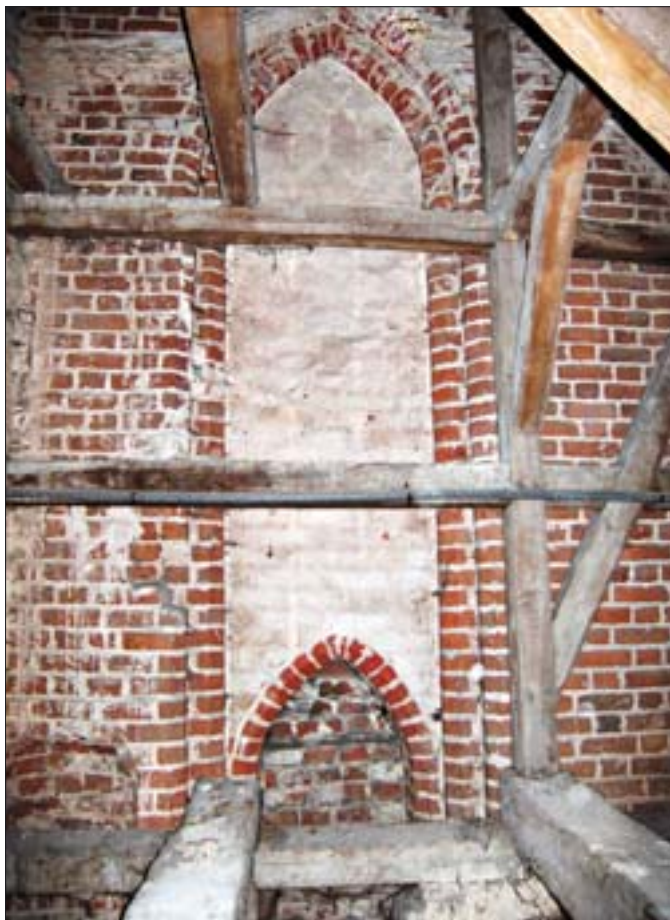
8. Blenda nr 1, widok ogólny. 8. Blind window no. 1, general view.
