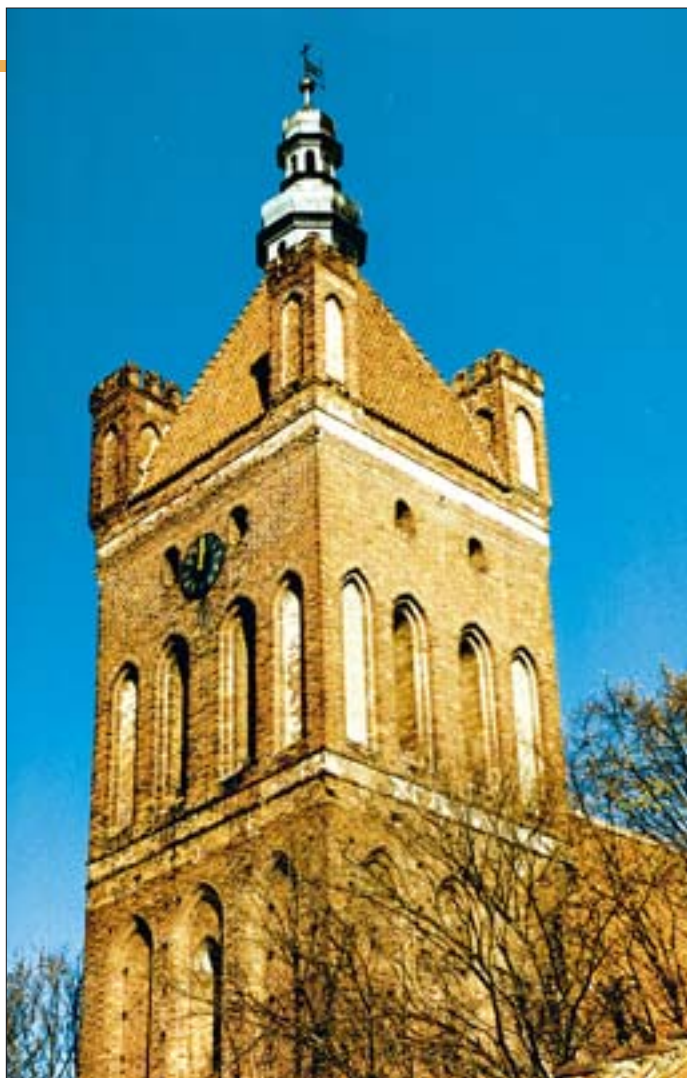
14. Golub, pozostałości dekoracji maswerkowych w tynkowanych polach gzymsów i blend elewacji dzwonnicy z 1. poł. XIV w., widok od pd.-zach.
