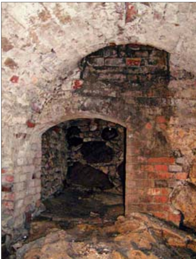
14. Odkryta piwnica kamienicy przy południowo-zachodnim narożniku ratusza.
