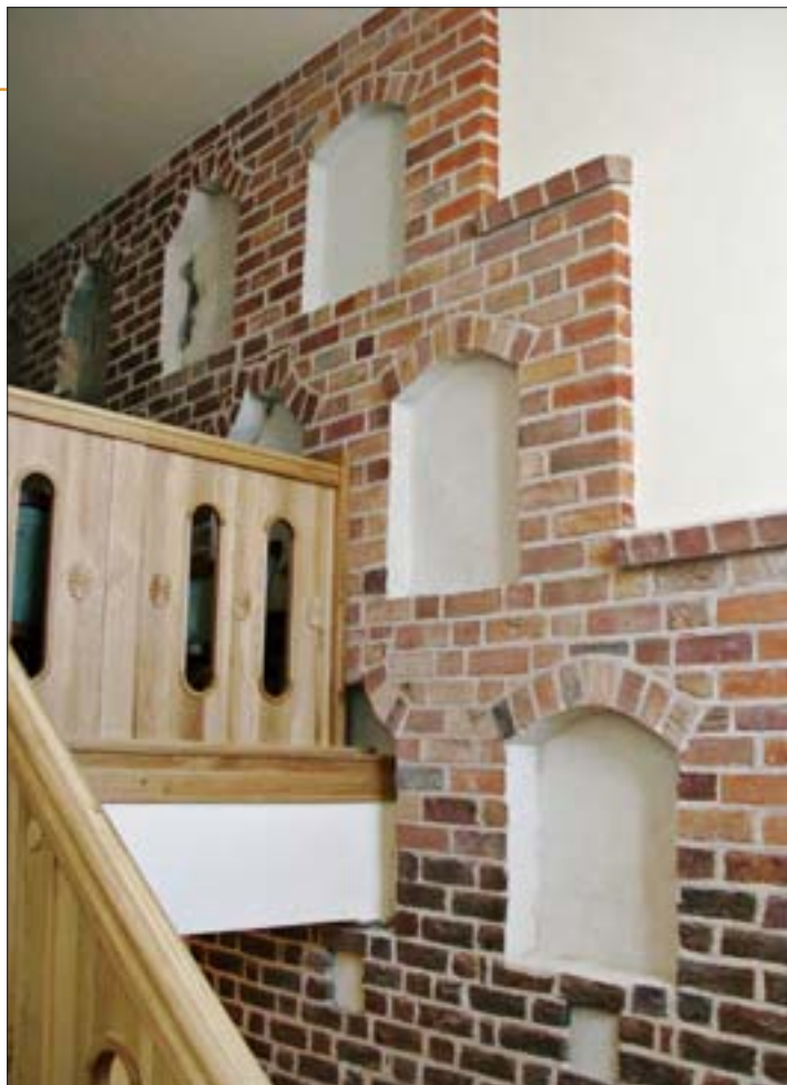
25. Zrekonstruowany fragment szczytu na wysokości trzeciej kondygnacji. 25. Reconstructed fragment of a gable at the level of the third storey.
