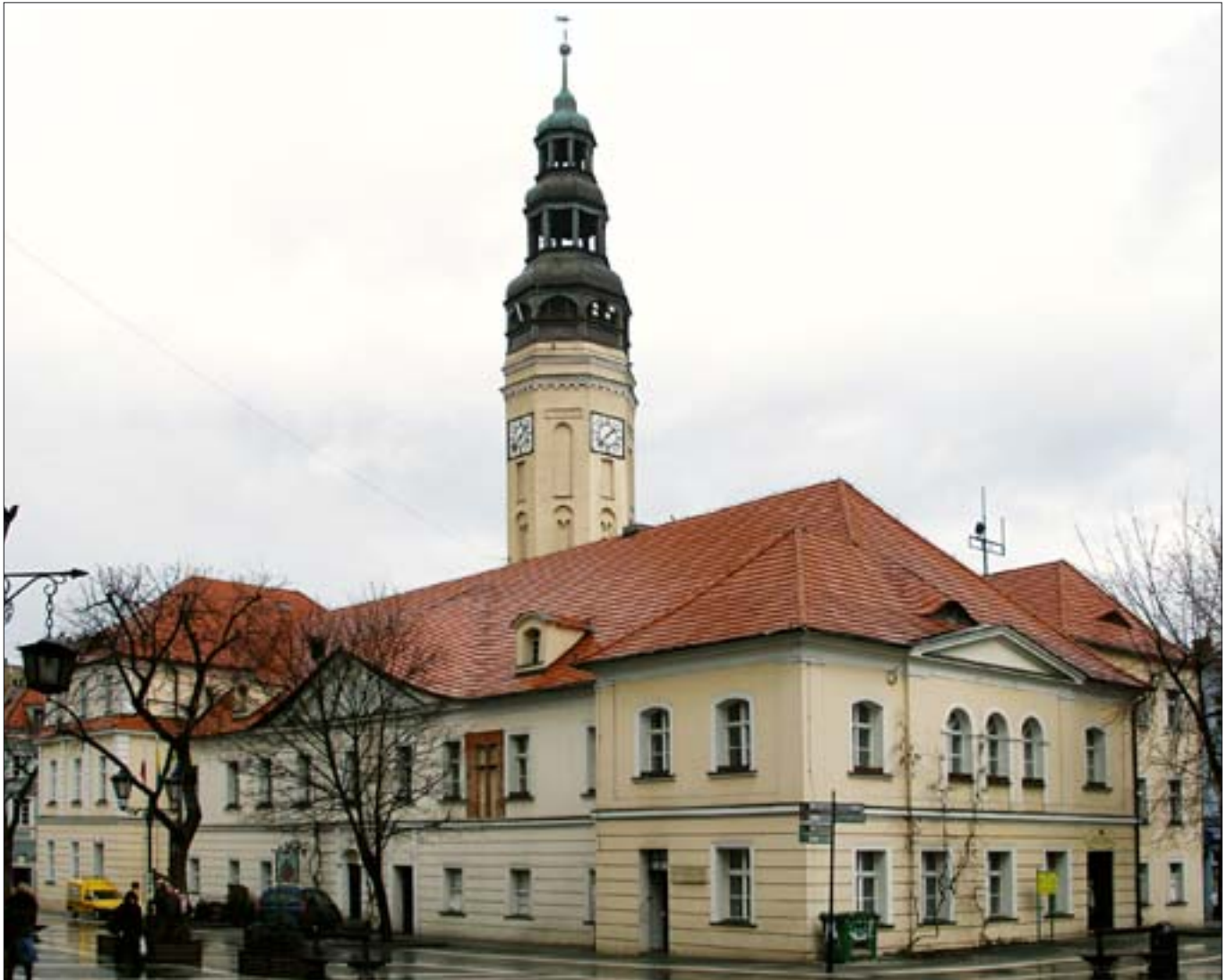
1. Ratusz, widok na elewację zachodnią i skrzydło południowe. Wszystkie zdjęcia autorki.
