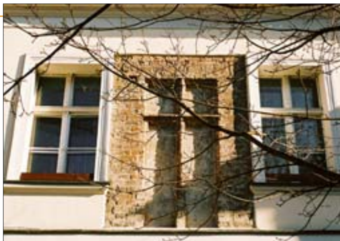
13. Ekspozycja blendy w elewacji zachodniej. 13. Exposition of a blind window in the western elevation.
