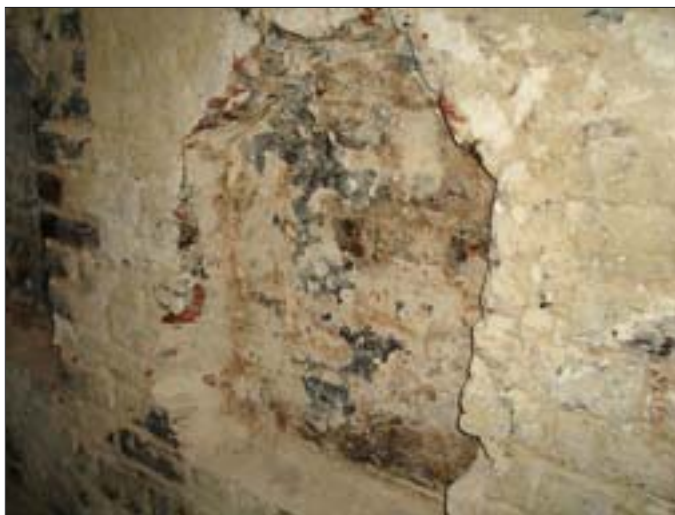
24. Blendy o łuku kotarowym w szczyście północnym gotyckiego ratusza. 24. Blind window with an arch in the northern gable of the Gothic town hall.
