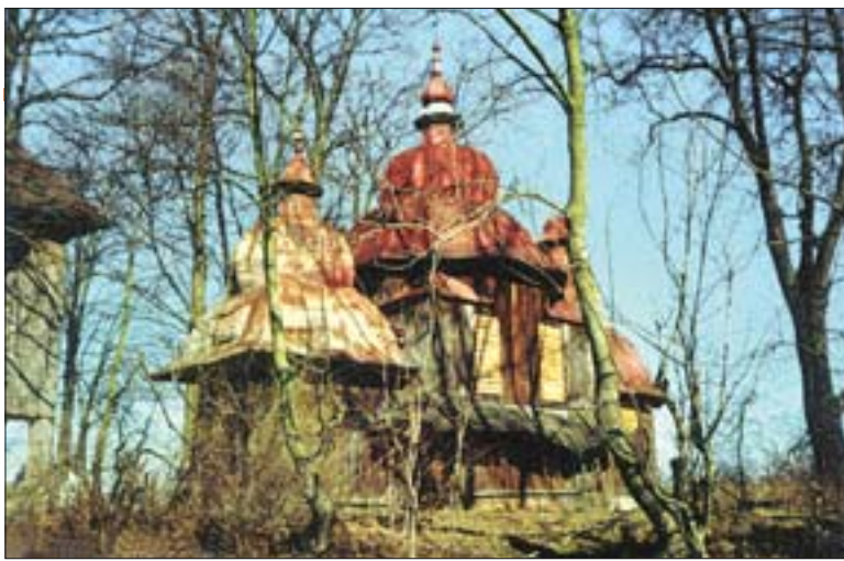
6. Opaka. Cerkiew p.w. Narodzenia NMP, stan przed pożarem w dniu 7 sierpnia 2003 r. Fot. P. Rydzewski.
