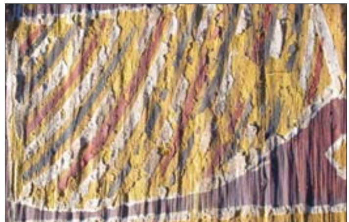
21. Przykłady łuszczącej się warstwy malarskiej. Fot. B. Tworek. 21. Examples of flaking paint. Photo: B. Tworek.
