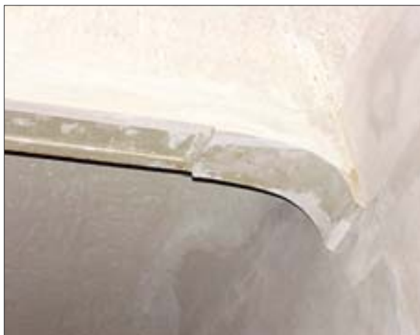
40. Pokój bilardowy, fragment dekoracyjnej belki na suficie po uzupełnieniu ubytków tynku. Profile belki w trakcie murowania ściany przedzielającej pomieszczenie na dwa mniejsze zostały częściowo zniszczone. Fot. D. Markowski.
