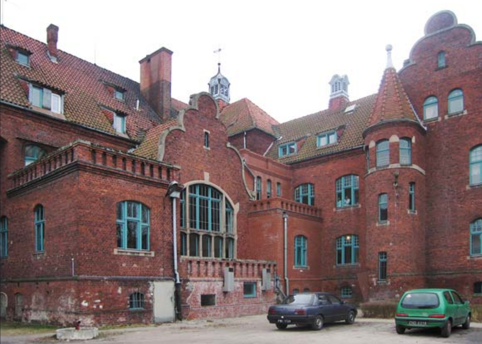
22. Elewacja tylna budynku sanatoryjnego. Fot. B. Bielinis-Kopec. 22. Rear elevation of the sanatorium building. Photo: B. Bielinis-Kopec.
