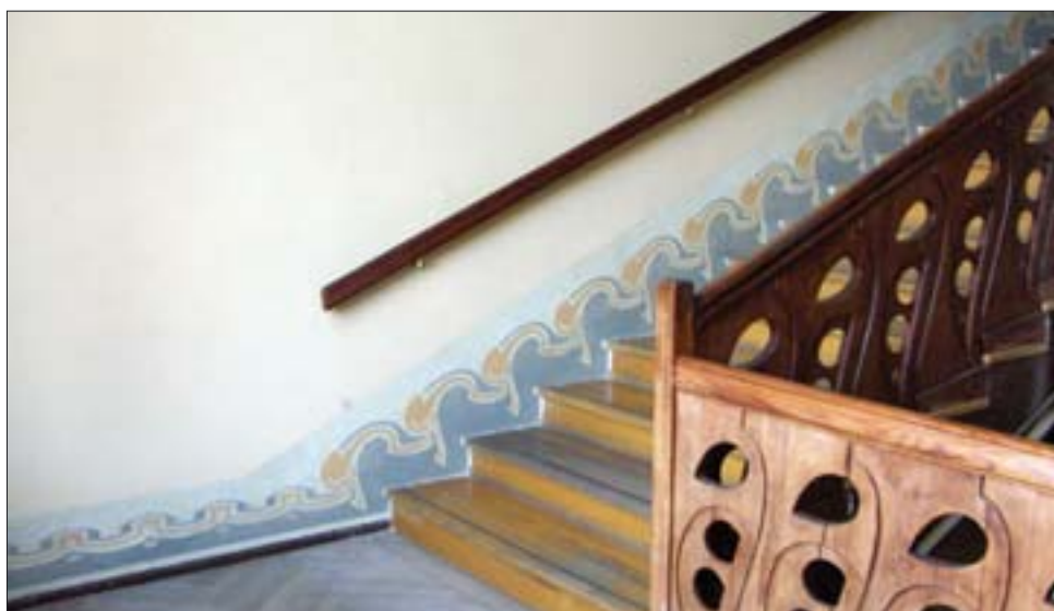
43. Schody w holu budynku głównego, przenoszenie szablonu rysunku ornamentu przed wykonaniem rekonstrukcji niezachowanych fragmentów dekoracji malarskiej. Fot. D. Markowski.
