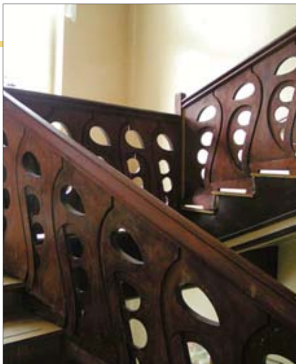
21. Balustrada klatki schodowej w budynku sanatoryjnym. Fot. B. Bielinis-Kopeć.
