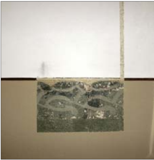
28. Odkrywanie dekoracji malarskiej (lamperia) na klatce schodowej w budynku administracyjnym. Fot. D. Markowski. 28. Uncovering painted decoration (wainscot) in the administrative building staircase. Photo: D. Markowski.
