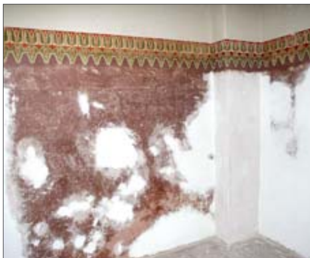
41. Pokój bilardowy, fragment ściany po uzupełnieniu ubytków tynku, w trakcie uzupełniania ubytków polichromii. Fot. D. Markowski.
