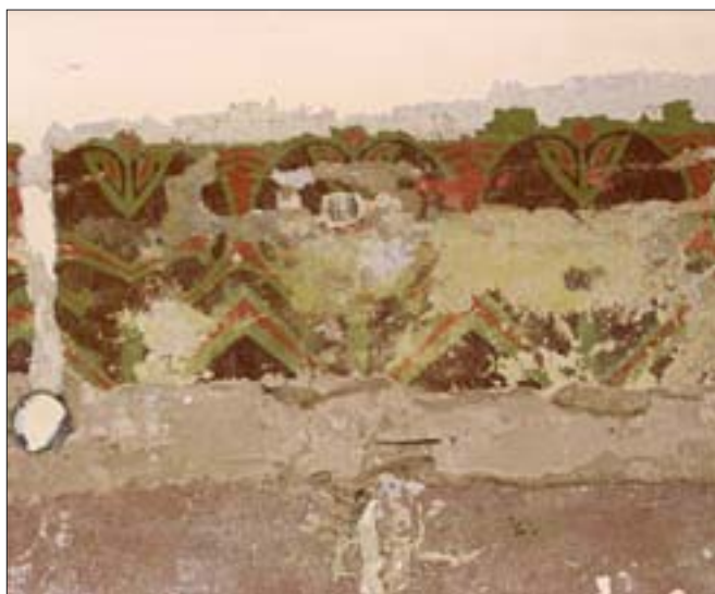
34. Pokój towarzyski I w budynku głównym, fragment dekoracji malarskiej w trakcie usuwania warstw przemalowań. Na zdjęciu widoczne zniszczenia polichromii. Fot. D. Markowski.
