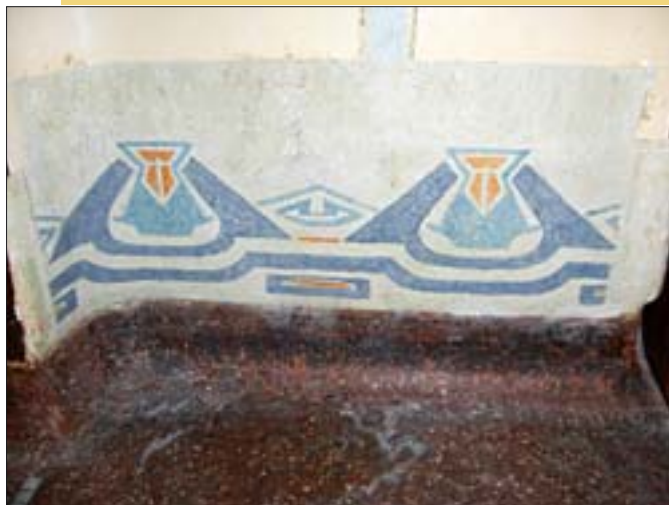
30. Odkrywka dekoracji malarskiej biegnącej przy stopniach schodów w holu budynku głównego. Fot. D. Markowski.
