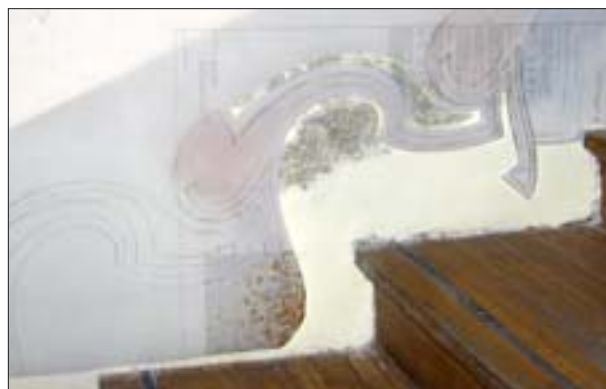
43. Schody w holu budynku głównego, przenoszenie szablonu rysunku ornamentu przed wykonaniem rekonstrukcji niezachowanych fragmentów dekoracji malarskiej. Fot. D. Markowski.
