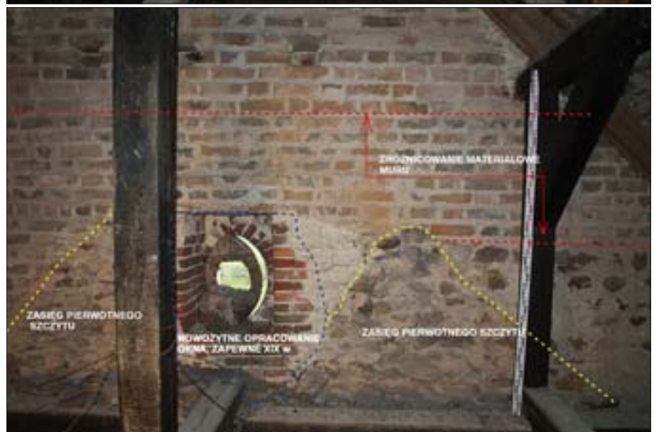
10a. Strych nad prezbiterium lico ściany wschodniej.
