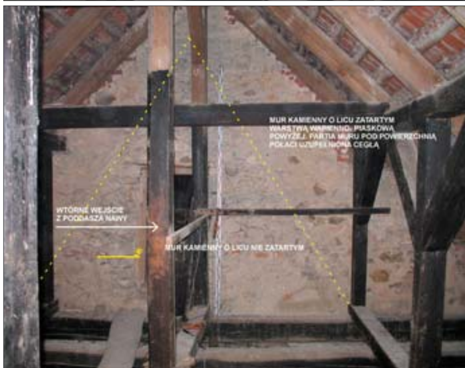
11. Strych nad prezbiterium ściana zachodnia z odciskami pierwotnej więźby. 11. Attic over the presbytery – the western wall with traces of the original roof truss.
