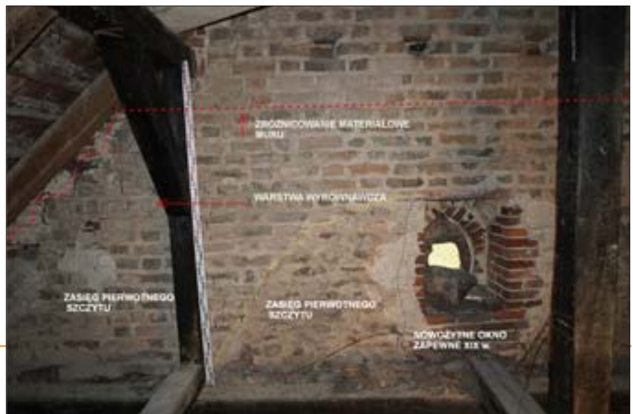
9. Zamurowany otwór w ścianie tęczowej na poziomie stropu nad nawą. Pierwotnie przejście do przestrzeni więzby dachowej nad prezbiterium. Aktualnie poniżej poziomu sklepienia prezbiterium. Zachowany ślad oporu szalunku nadproża.
