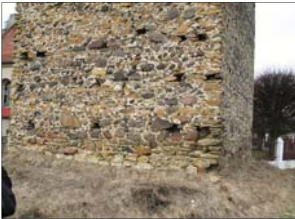
15. Ściana dzwonnicy z widocznymi otworami po belkach rusztowania.
