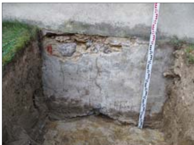
19. Wykop nr 4. 19. Dig no. 4.
