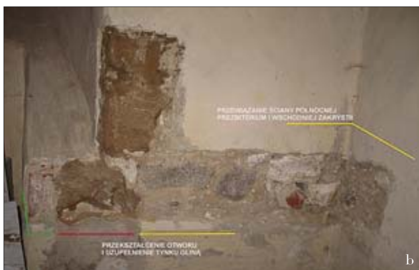
4. Zakrystia, a – widok w kierunku wschodnim; b – ściana wschodnia, ościeże południowe.
