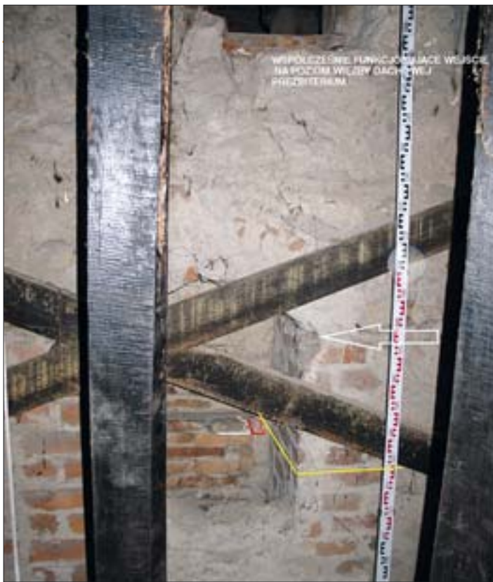
9. Zamurowany otwór w ścianie tęczowej na poziomie stropu nad nawą. Pierwotnie przejście do przestrzeni więzby dachowej nad prezbiterium. Aktualnie poniżej poziomu sklepienia prezbiterium. Zachowany ślad oporu szalunku nadproża.
