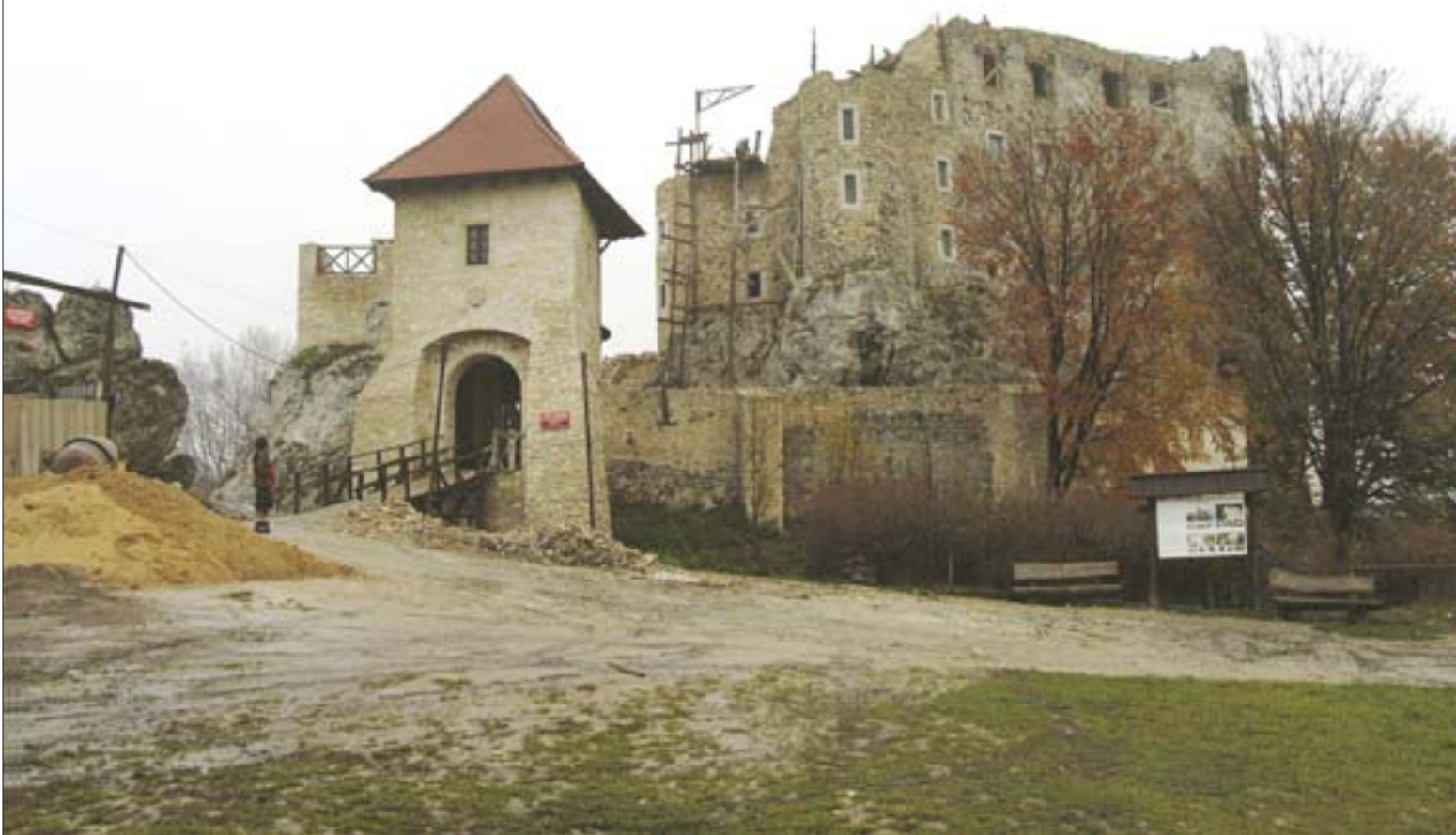
5. Bobolice, ruiny zamku – wpisane do rejestru zabytków nieruchomości w 1960 r. oraz rejestru zabytków archeologicznych w 1978 r. – w trakcie budowy. Fot. I. Malawska, 2007 r. 5. Bobolice, castle ruins included into the register of immobile monuments in 1960 and the register of archaeological monuments in 1978; undergoing construction. Photo: I. Malawska, 2007
