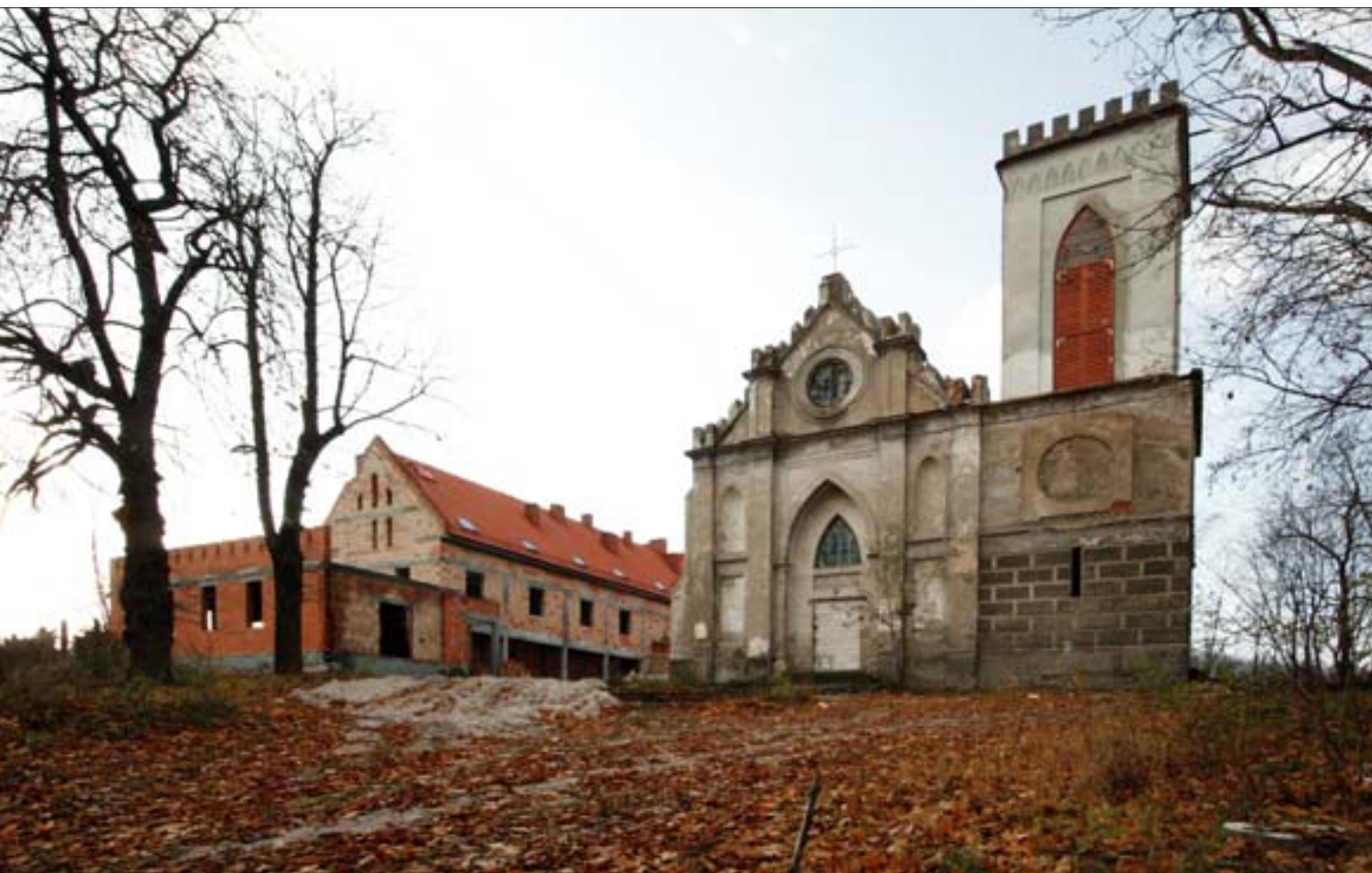
8. Gostynin, zespół zamkowy, pozostałości murów zamkowych i kaplica z basztą – wpisane do rejestru zabytków nieruchomych w 1962 r. – w trakcie budowy. Fot. M. Warchoń, 2007 r.
