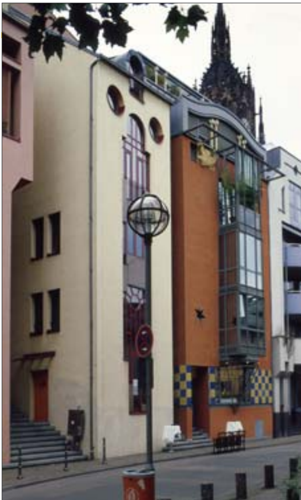
19. Postmodernistyczna zabudowa nawiązująca do historycznej zabudowy szczytowej. Frankfurt nad Menem, Saalgasse, między katedrą i ratuszem. Architekci: Bangert, Jansen, Scholz, Schultes. Fot. R. Eysymontt. 19. Postmodernist housing referring to historical gable construction. Frankfurt on the Main, Saalgasse, between the cathedral and the town hall. Architects: Bangert, Jansen, Scholz, Schultes. Photo: R. Eysymontt.
