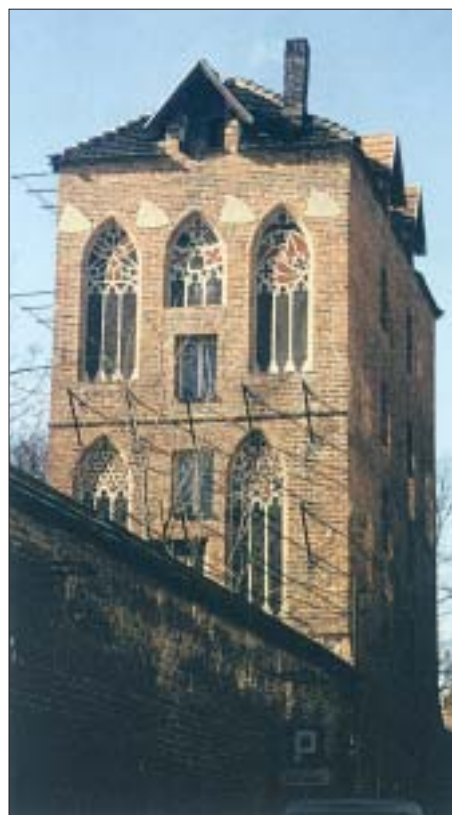
3. XIV-wieczna baszta miejska w Toruniu, na której konserwator pruski w poł. XIX w. polecił wykonać godła krzyżackie na tarczach w tynku. Poniżej nich, w blendach, rekonstrukcja dekoracji gotyckich, wykonana w 2003 r.
