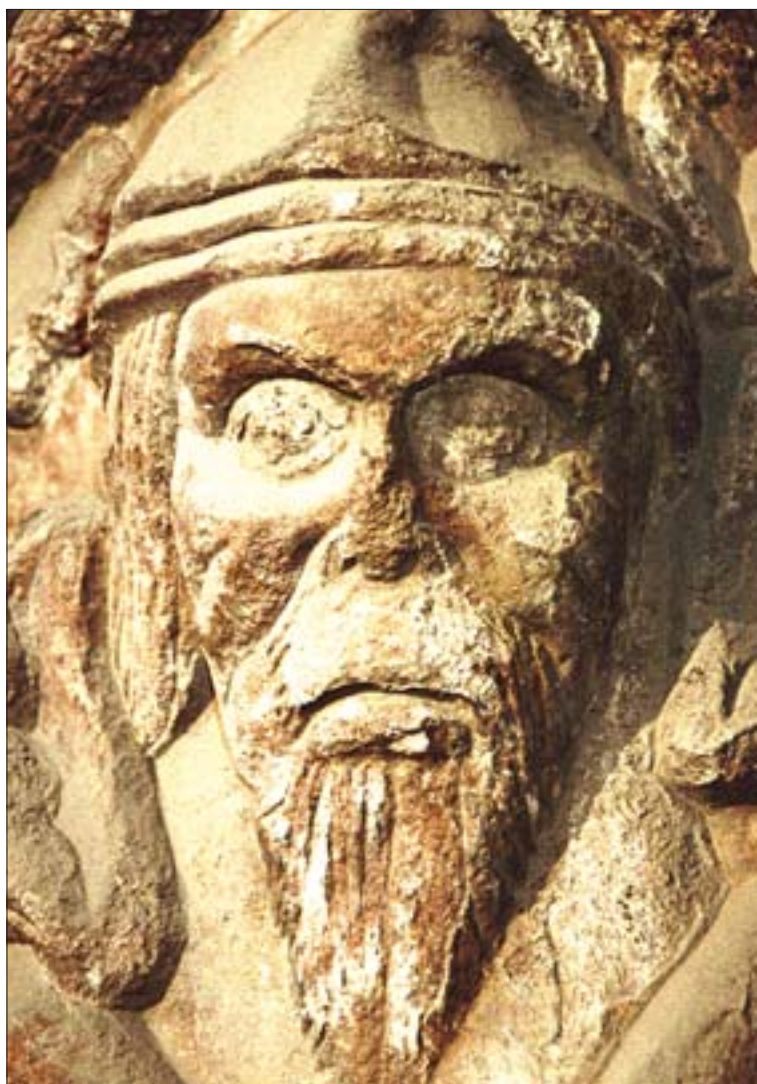
23. Wrocław. Fragment portalu z Ołbina, kilkakrotnie nasączony fluorokrzmianami, impregnowany żywicą epoksydową w 1968 r., podlega dalszej destrukcji 11 . Fot. J. Michniewicz.
