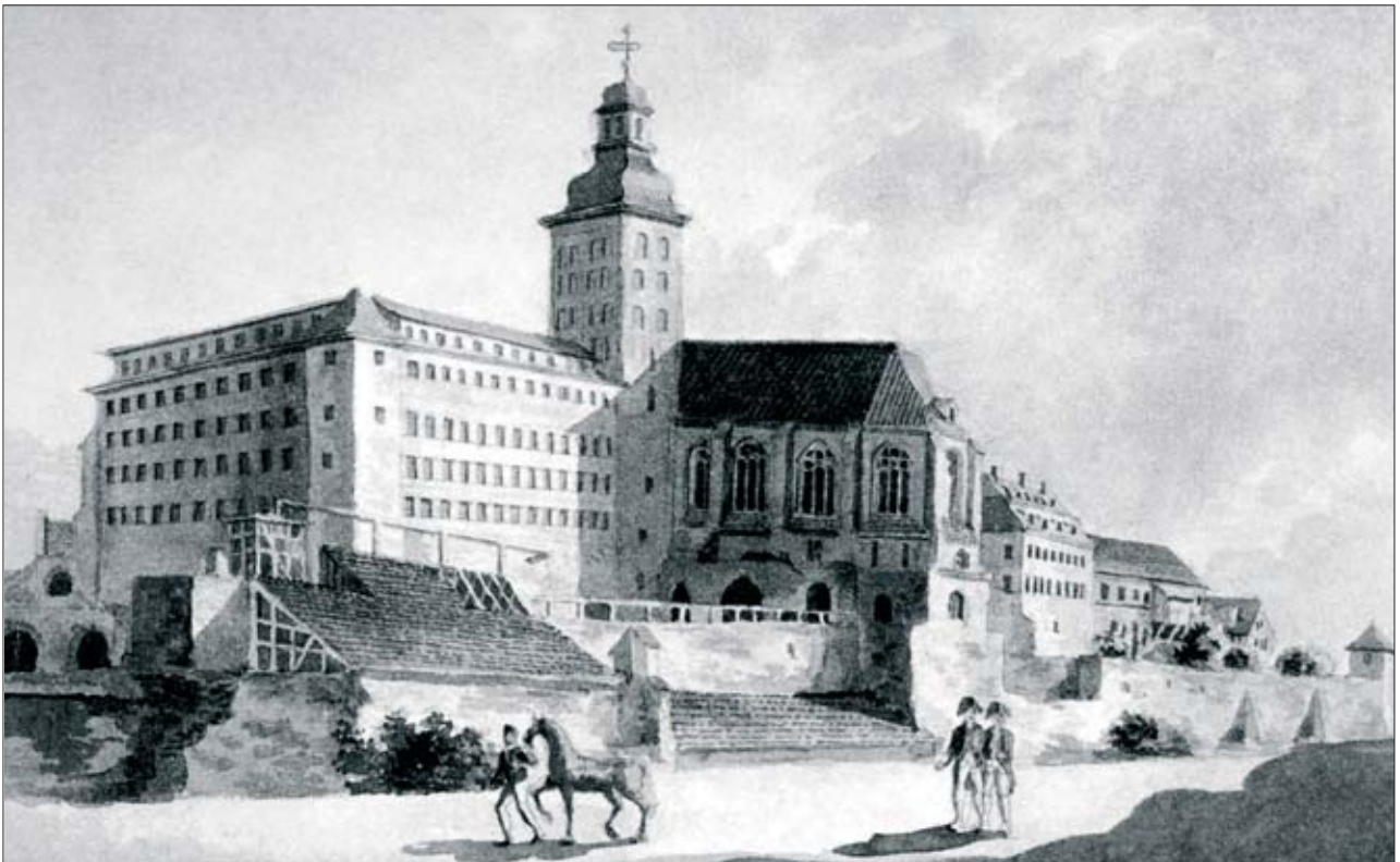
3. Widok zamku od południowego wschodu, 1802. Zwracają uwagę liczne otwory okienne, przebudowane dachy, brak fortyfikacji. Po prawej stronie bryła kolegium jezuickiego. Ściany zewnętrzne zostały wówczas otynkowane. Autor nieznan, repr. z: M. Kilariski, Odbudowa i konserwacja zespołu zamkowego w Malborku w latach 1945-2000 , Malbork 2007, s. 15.
