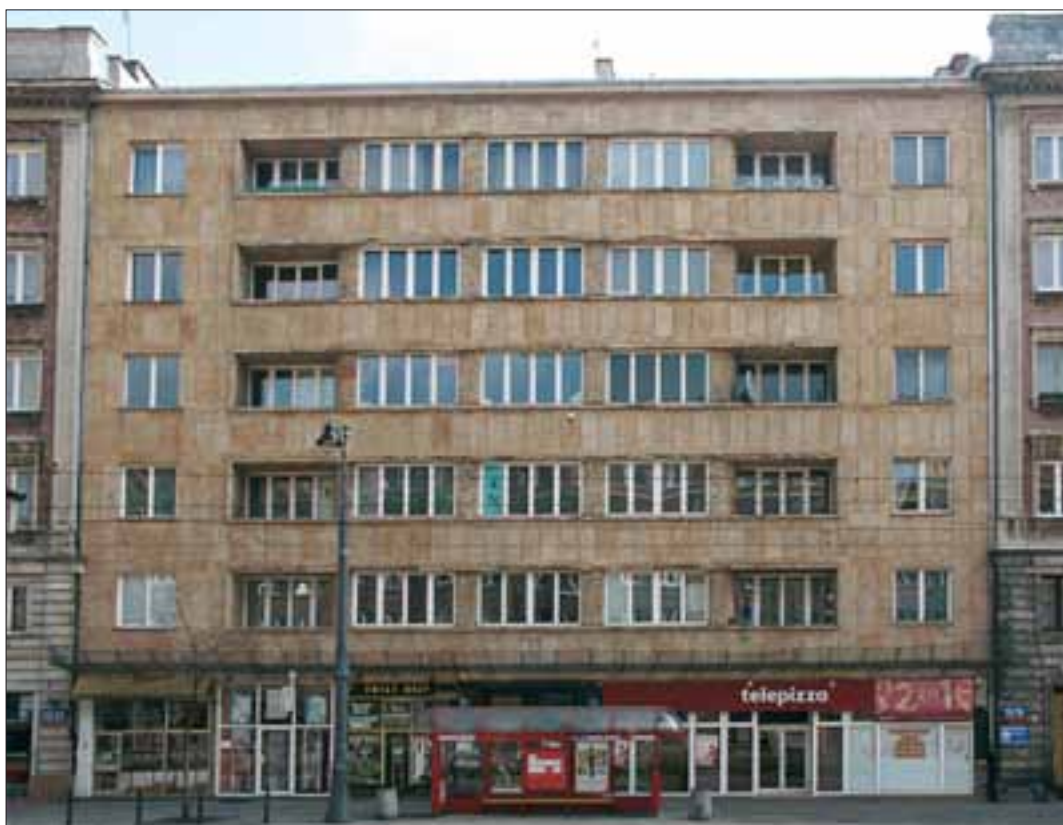
12. Warszawa, ul. Marszałkowska 18, kamienica modernistyczna – „Dom Robinsonów”, wzniesiona w latach 1935-1936, niewpisana do rejestru zabytków. Fot. M. Gawlicki. 12. Warszawa, 18 Marszałkowska Street, modernist town house – the “Robinson House”, erected in 1935-1936, not in the register of historical monuments. Photo: M. Gawlicki.
