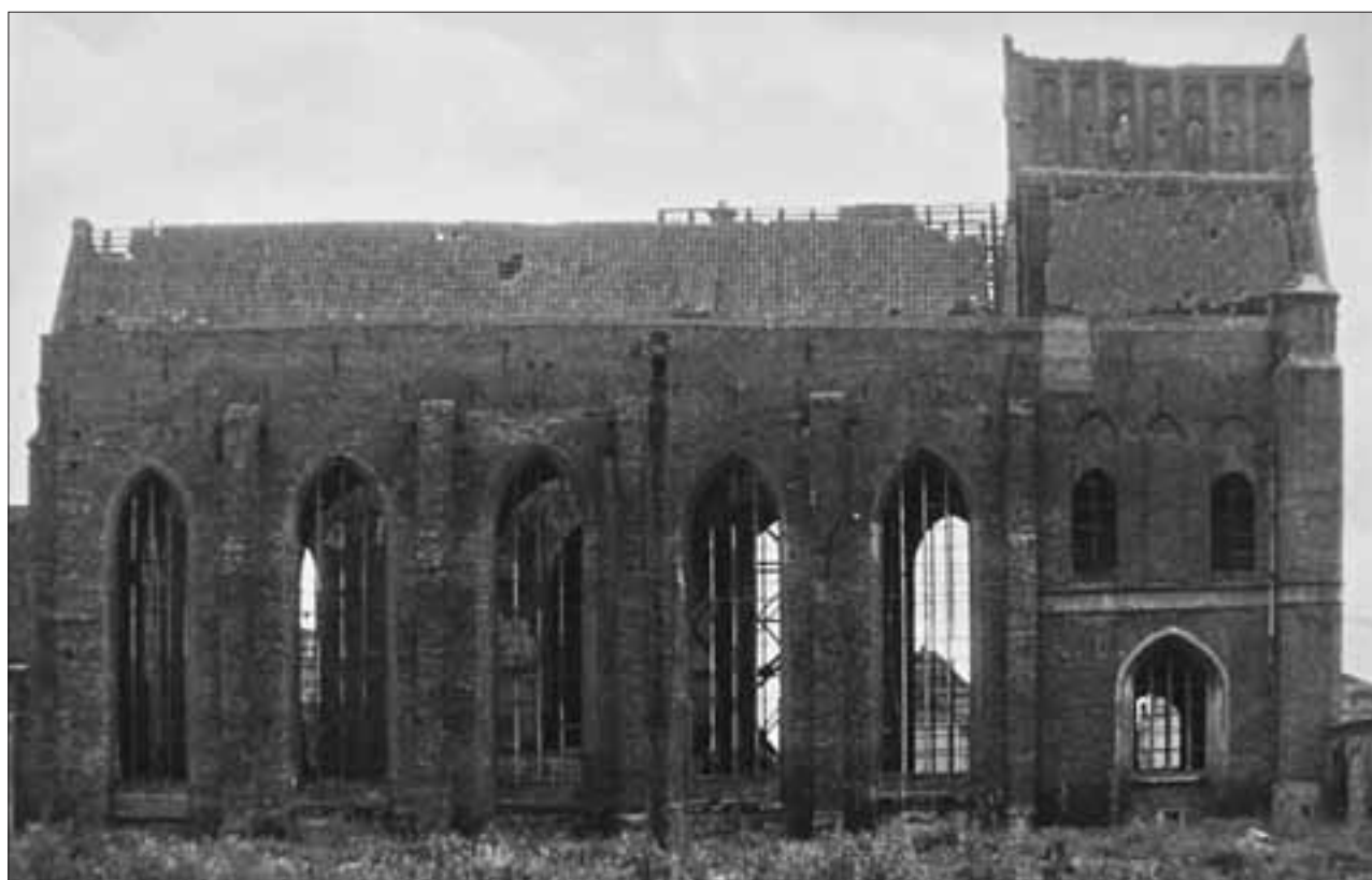
4. W latach 60. i 70. XX w. nadal wiele zniszczonych podczas wojny i w latach powojennych cennych zabytków znajdowało się w stanie ruiny. Kościół pw. św. św. Piotra i Pawła w Gdańsku, widok od strony północnej. Fot. ze zbiorów ROBiDZ w Gdańsku.
