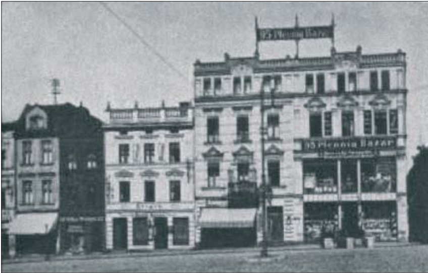
14. Północna część pierzei zachodniej – widok sprzed wojny i po odbudowie. Źródło: Internet, stan z września 2008 r. Fot. autor.
