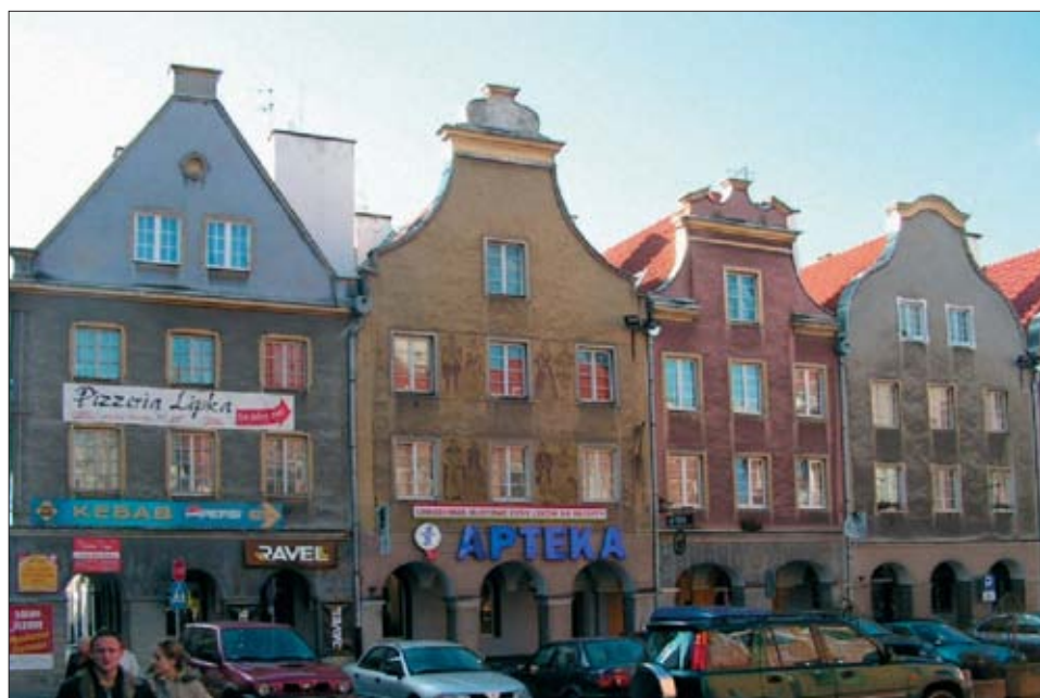
13. Pierzeja południowa – widok sprzed wojny i po odbudowie. Źródło: Internet, stan z września 2008 r. Fot. autor. 13. Southern row of houses – view from the inter-war period and after reconstruction. Source: Internet, state from September 2008. Photo: author.
