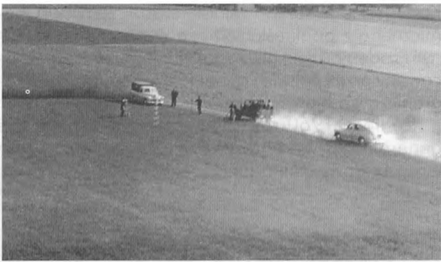
Geodeci na przyszłym placu budowy Kombinat
