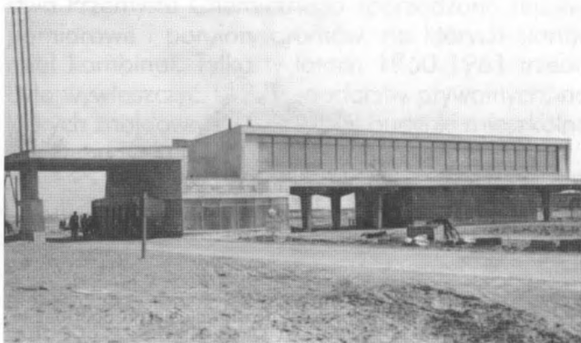
Budynek portierni i Bramy nr 1 w budowie
