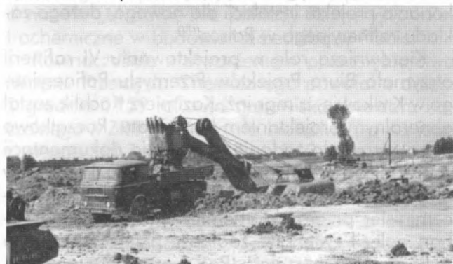
Pierwsze prace ziemne na placu budowy MZRiP
