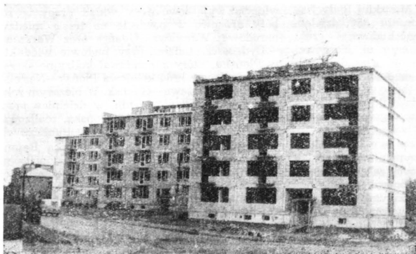
Osiedle mieszkaniowe rad narodowych przy ul. Wolności — w budowie. Składa się z 6 budynków czterokondygnacyjnych dla około 200 rodzin. Wartość 44 mln. zł (łącznie z urządzeniami komunalnymi).
