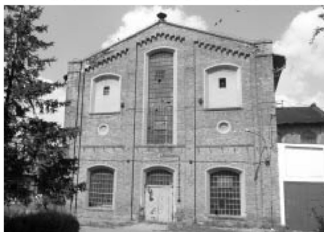
Fot. 3. Główna hala produkcyjna d. cukrowni z lat 70. XIX wieku, przebudowana w 1922 r. – widok skrzydła południowego. Foto autora 2010 r.
