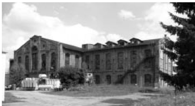
Fot. 1. Główna hala produkcyjna d. cukrowni z lat 70. XIX wieku, przebudowana w 1922 r. – widok od strony zachodniej. Foto autora 2010 r.
