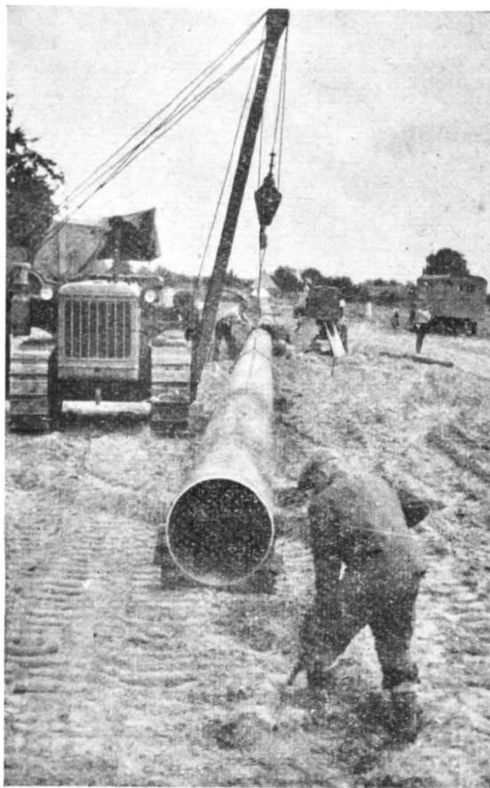
Prace przy budowie ropociągu
