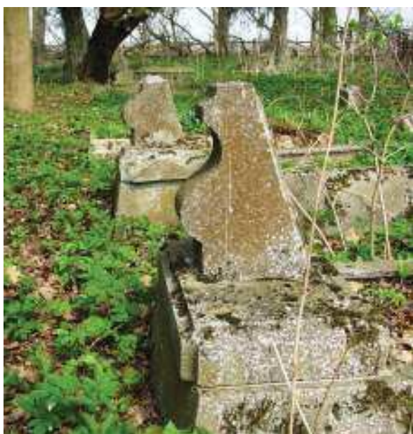
Przykłady podpór wykonanych z lastriko w formie esowatego zagłówka.
