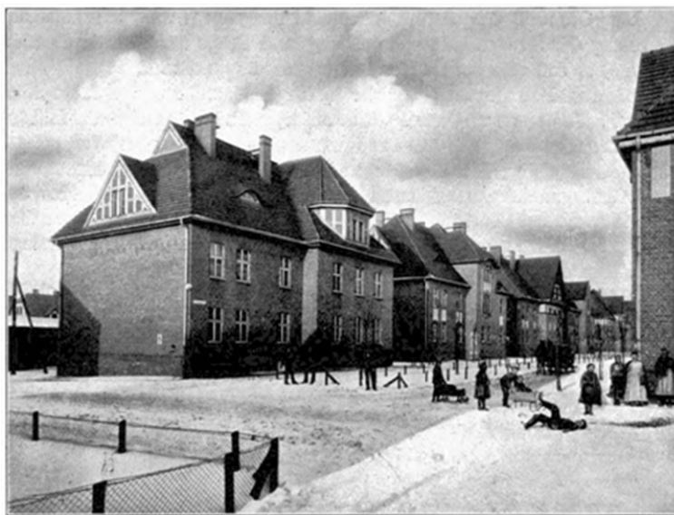
Abb. 119. Kolonie der Dubenskogrube. Sechsfamilienhäuser. (Vergl. Abb. 122.)
