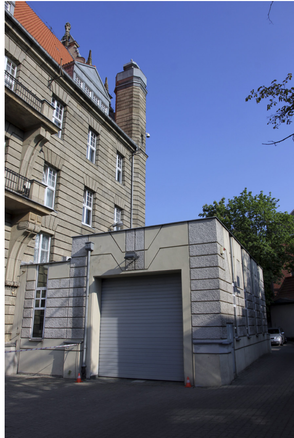
3. Tzw. przeładunek, w pełni zmechanizowana śluza w formie przybudówki (2015)
