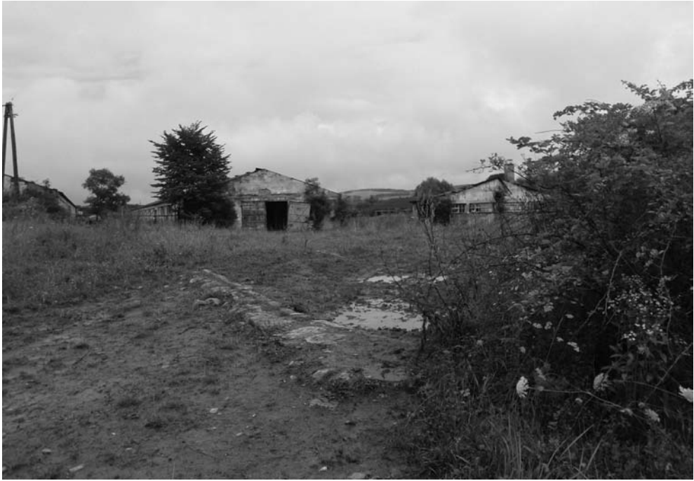
II. 4. Zarastające trawą i krzakami budynki byłego PGR w Karlikowie. Fot. A.G.
