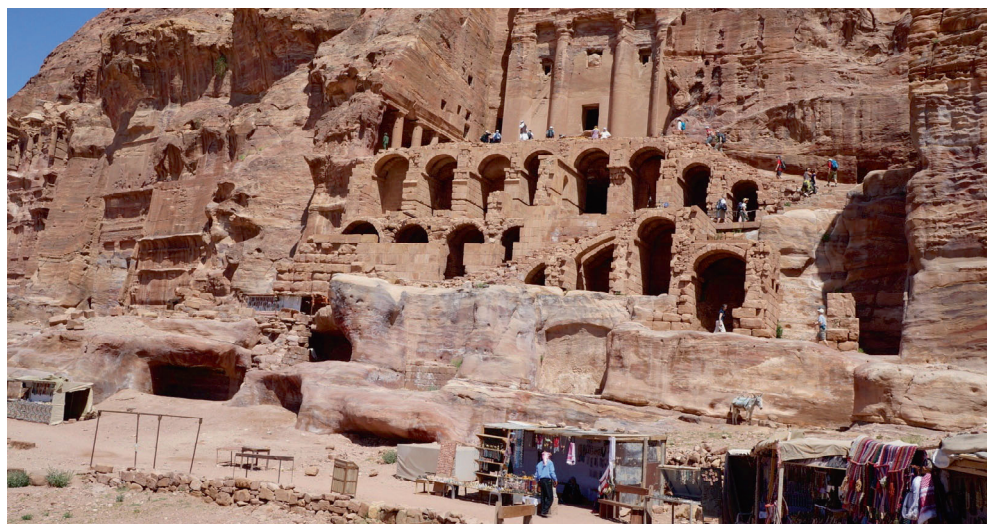
Fot. 3. Dolne partie fasady Deir (klasztor) zniszczone przez procesy erozyjne – działanie wiatru oraz wdrapujących się na zabytkowe budowle turystów
