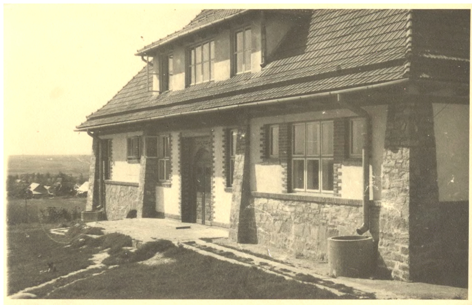
Budynek Wiejskiego Uniwersytetu Orkanowego na Gackiej Górze od frontu (1937)
