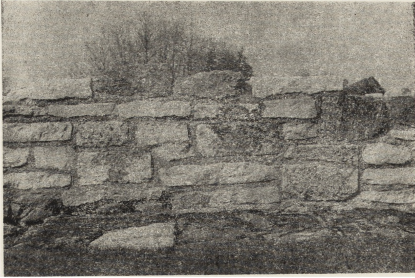
Ryc. 230. Kirkham — opactwo. Przykład konserwacji wstępu muru.
