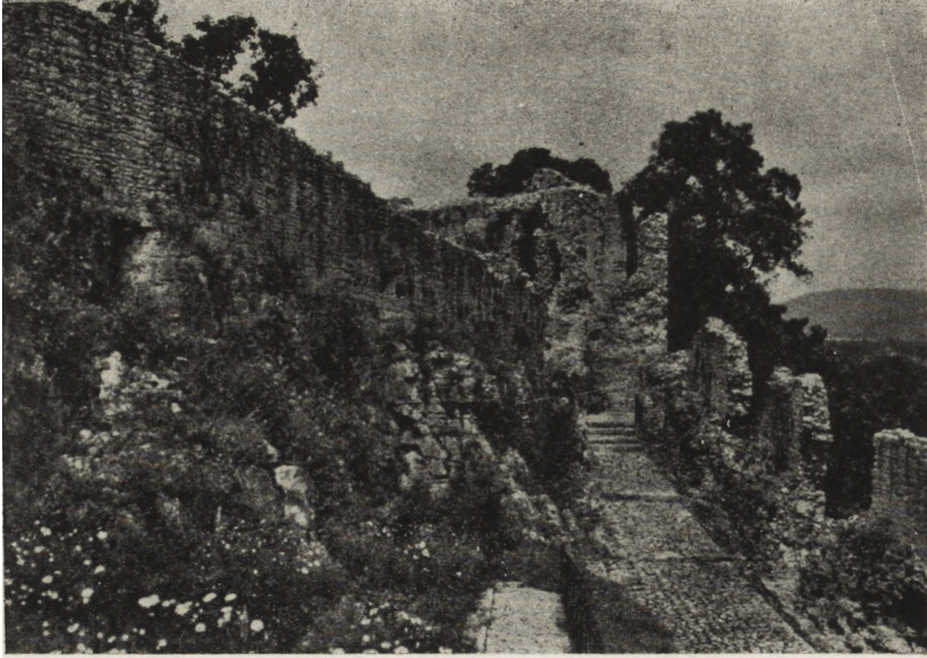
Ryc. 239. Denbigh — ścieżki i schody kamienne w murach obronnych.
