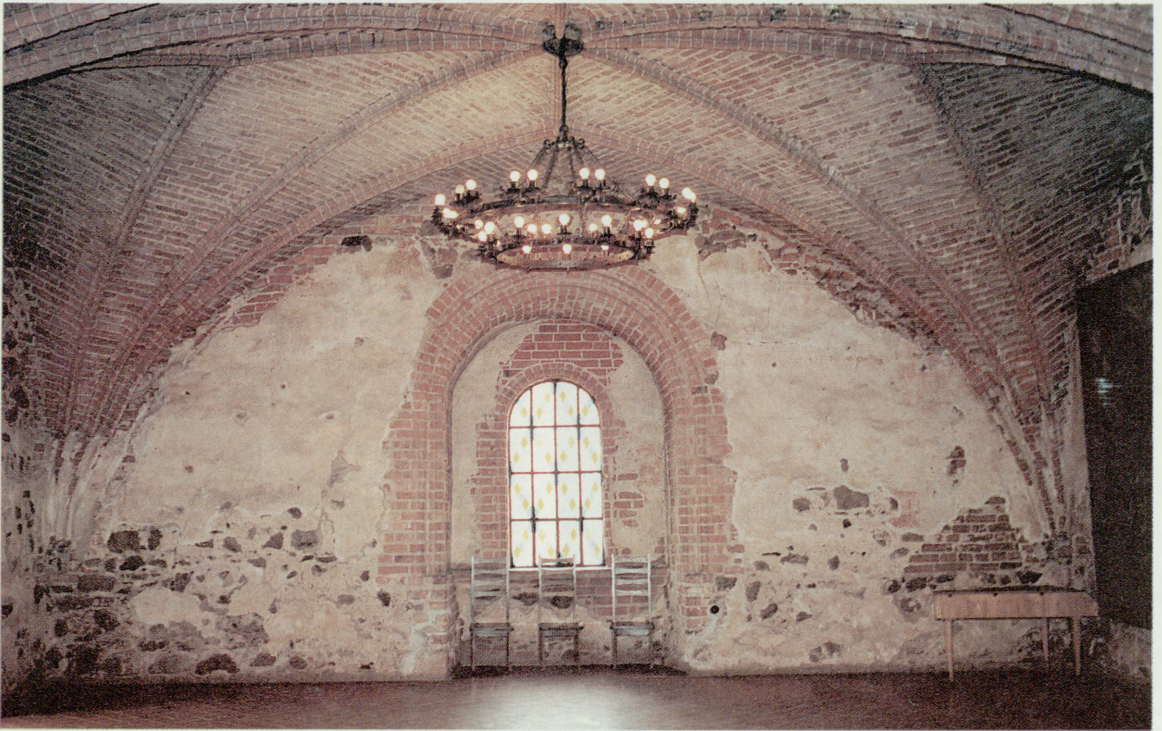
A. Troki, zamek na wyspie po odbudowie, sala w południowym skrzydle, ściana południowo-zachodnia z fragmentami oryginalnych tynków pod malowidła, 1410-1470 (?), stan obecny. Fot. A. Szymańska A. Troki, the castle on an island after reconstruction, chamber in the south wing, south-west wall with fragments of original plaster foundation of paintings, 1410-1470 (?). Photo: A. Szymańska
