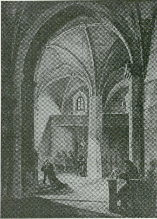
3. Lublin, kościół Trójcy Św. na zamku, wewnątrz z 1852-1853 r. wg „Albumu” K. Stronczyńskiego (VI, tabl. 4). Neg. w Gab. Ryc. BUW 3. Lublin, the castle church of Holy Trinity, interior from 1852-1853, according to „Album” by K. Stronczyński (Atlas VI, table 4). Negative in Gab. Ryc. BUW
