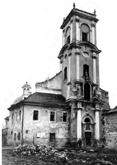
20. Kamieniec Podolski, kościół podominikański, wiek XV i 1737–1755, widok od pn.–zach., przy wieży domek Michała Franciszka Potockiego, fundatora odbudowy z lat 1737–1755, stan przed pracami konserwatorskimi. Fot. R. Brykowski, 1997 r.
