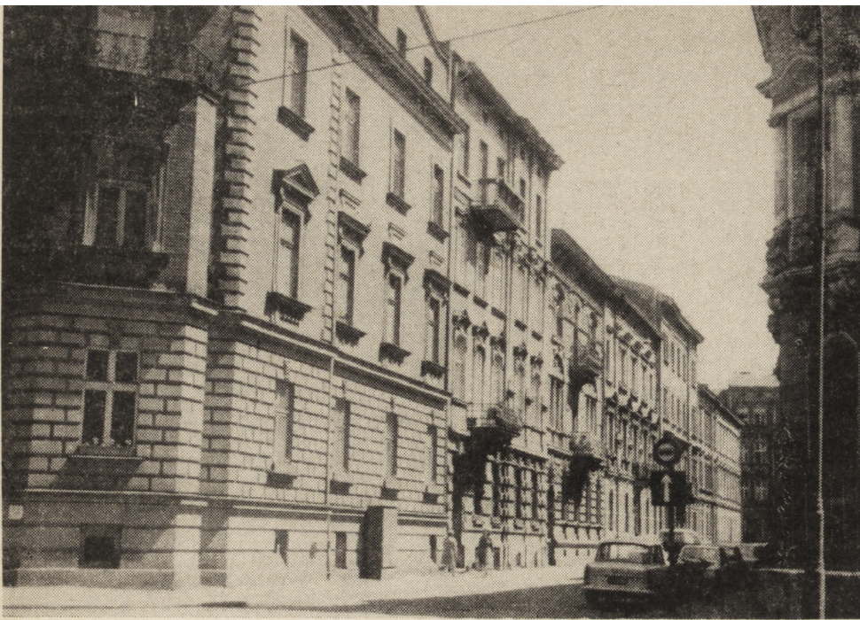
3. Kraków, ul. Zamenhofa (d. Pańska); obudowę nowo wytyczanych ulic śródmieścia w obrębie obwarowań z ok. 1860 r. stanowiły głównie 2- i 3-piętrowe kilkunastopiętrowe „kamienice” z ogrodami na zapleczu (fot. J. Bogdanowski)
