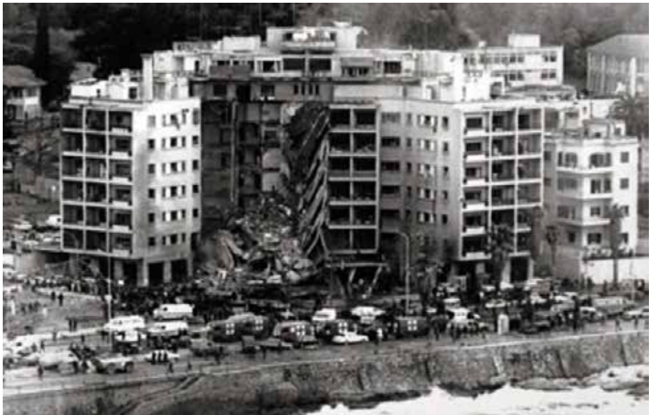
Zdj. 5. Ambasada USA w Bejrucie zniszczona w 1983 r. po samobójczym ataku bombowym.
