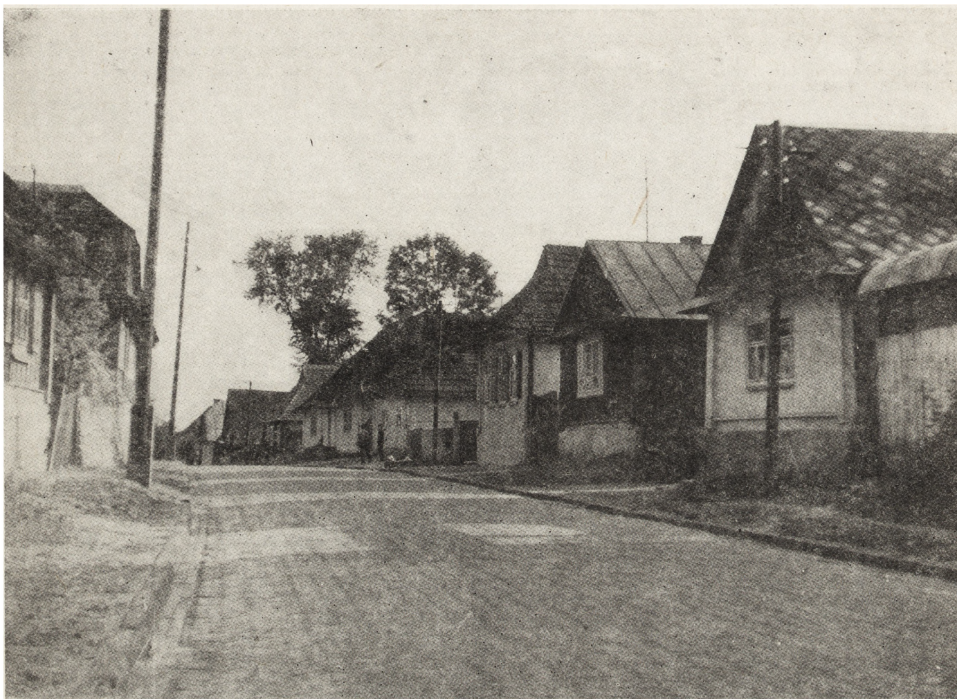
4. Bilgoraj (woj. zamojskie), domy mieszczańskie przy ul. Janka Krasickiego (fot. L. Kozakiewicz, 1965; neg. PKZ Warszawa) 4. Bilgoraj (Zamość voivodship), burgher's houses at Janka Krasickiego st.
