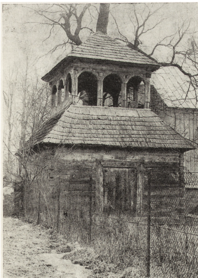
10. Rudno (woj. białopodlaskie), dzwonnica (fot. J. Kostek, 1976; neg. MWL).
