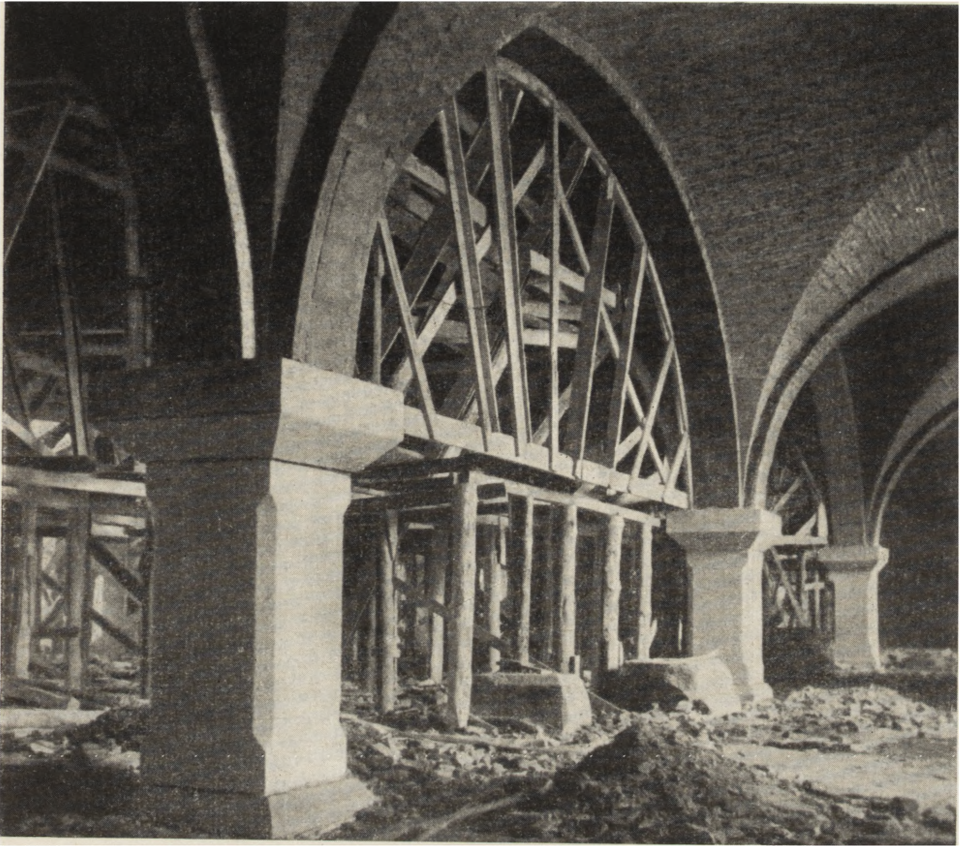
Ryc. 6. Gdańsk — Zbrojownia. Stan w czasie konserwacji.
