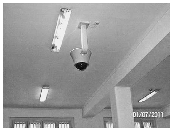
Rycina 7. Obrotowa kamera monitorująca salę chorych – materiał własny
