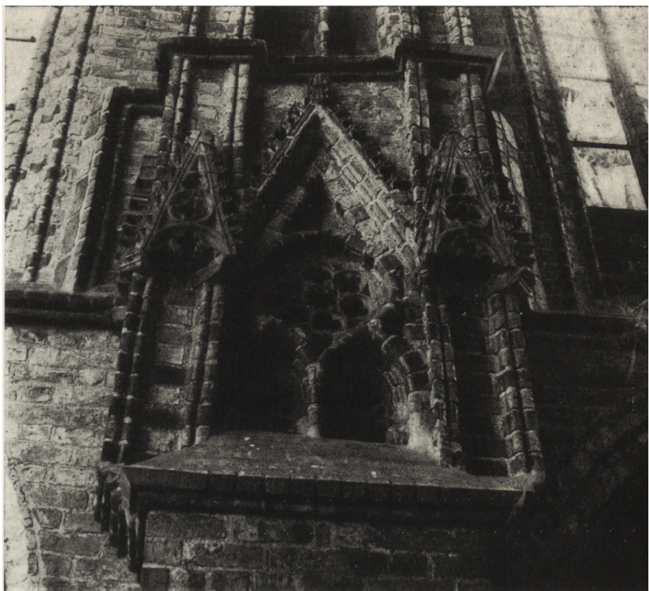
6. Chojna. Église Notre Dame. Lisène de la I-ère phase des travaux de construction de la façade du nord
