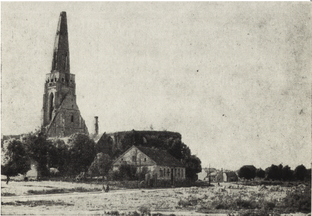
15. Chojna. Kościół NMP. Widok ogólny od południa (fot. ODZ 1960) 15. Chojna Église Notre Dame. Vue d'ensemble du côté sud
