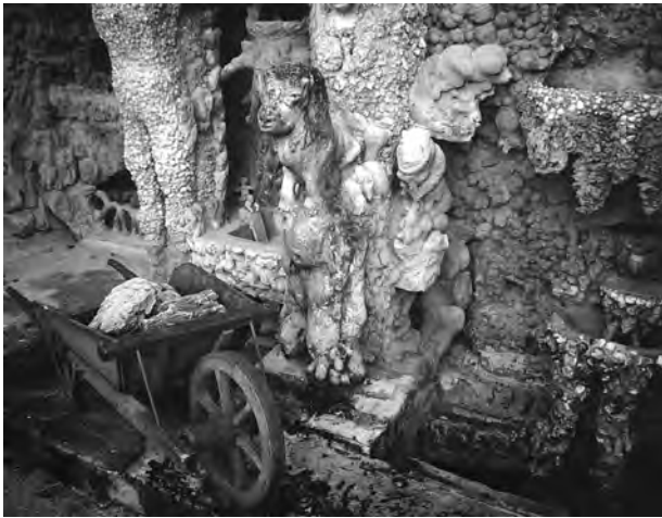
3. Po 33 latach pracy, 93 tysiącach godzin, po zużyciu 3500 worków wapna i 1000 m 3 kamieni, w 1912 r. budowa pałacu została zakończona
