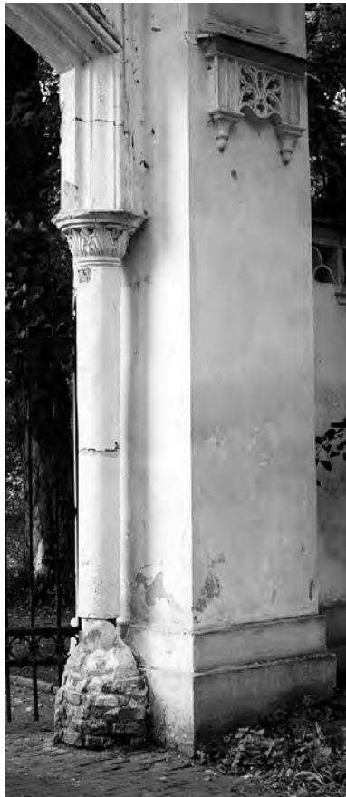
13. Brama mauretańska: a — fragment kolumny z widocznym spod odsjowanego tynku trzonem ceramicznym; b — kolumna, stan przed konserwacją; c — kolumna, stan po konserwacji. Fot. A. Koss
