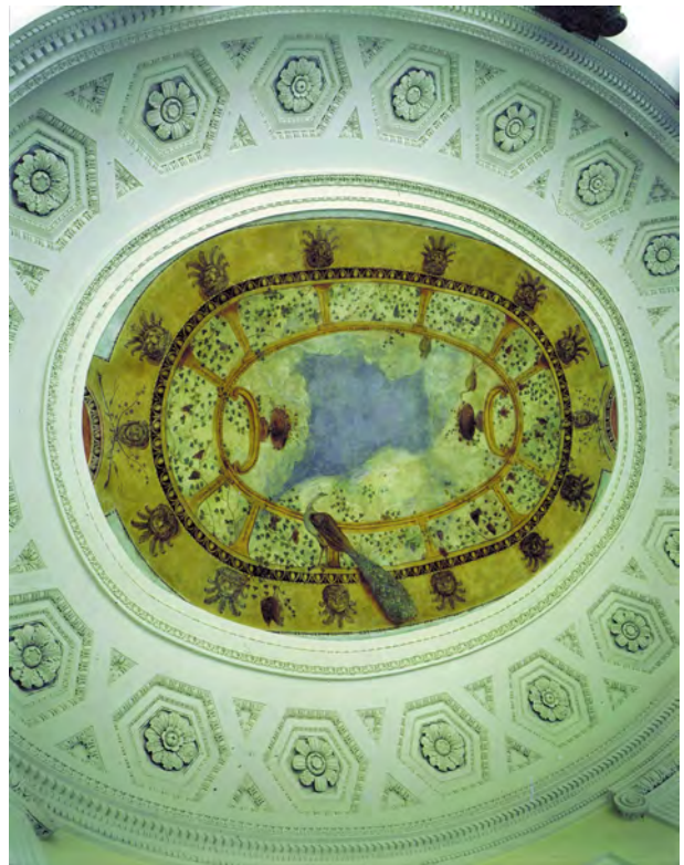
9. Plafon V. Brenny w Salonie Otwartym pałacyku, odsłonięty podczas restauracji w 1945 r. Fot. Z. i M. Siemaszko
