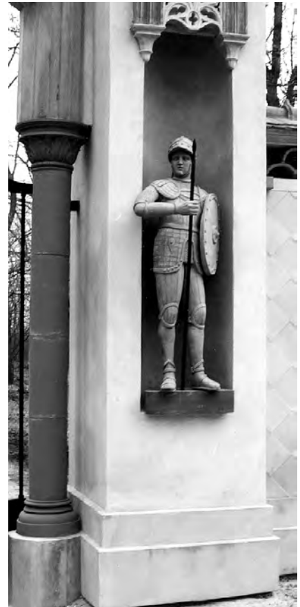
13. Brama mauretańska: a — fragment kolumny z widocznym spod odsjowanego tynku trzonem ceramicznym; b — kolumna, stan przed konserwacją; c — kolumna, stan po konserwacji. Fot. A. Koss
