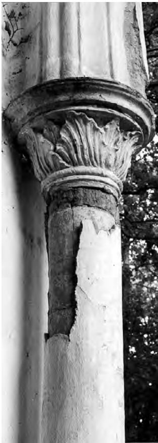
13. Brama mauretańska: a — fragment kolumny z widocznym spod odsjowanego tynku trzonem ceramicznym; b — kolumna, stan przed konserwacją; c — kolumna, stan po konserwacji. Fot. A. Koss
