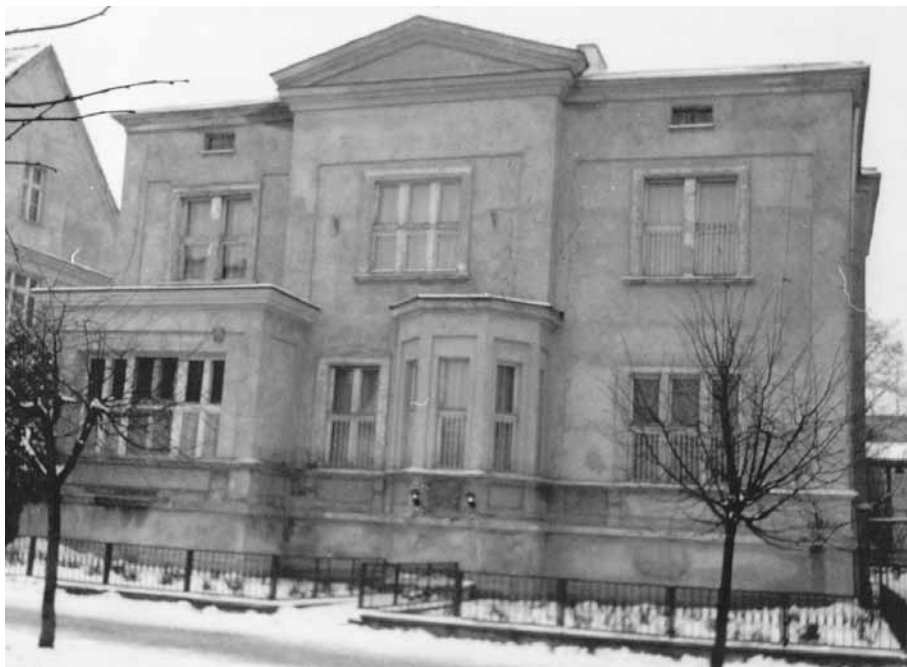
Były budynek gestapo w Działdowie
