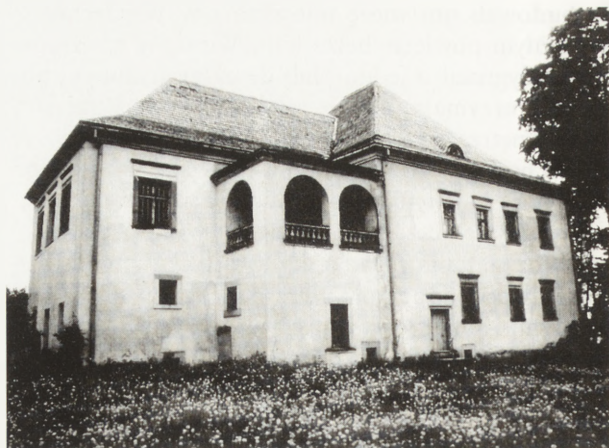
7. Niszczący dwór w Skotnikach, stan z 1995 r. Fot. Z. Błaszczyk
