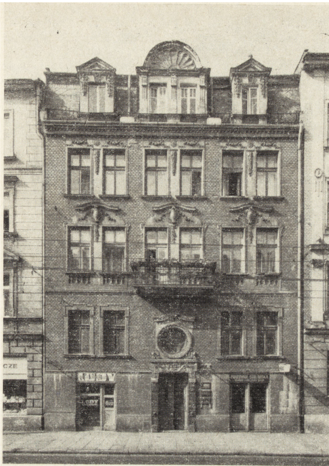
1. Kraków, elewacja kamienicy czynszowej przy ul. Bohaterów Stalingradu z początku XX w.
