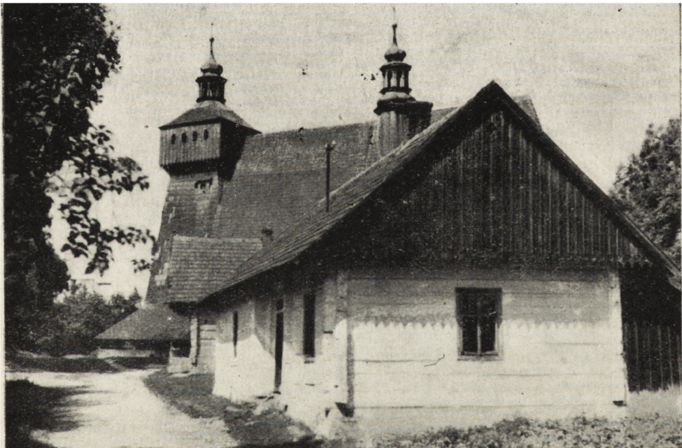
Ryc. 41. Haczów, pow. Brzozów — dom o dachu z wypustem; w głębi kościół, 1956.
