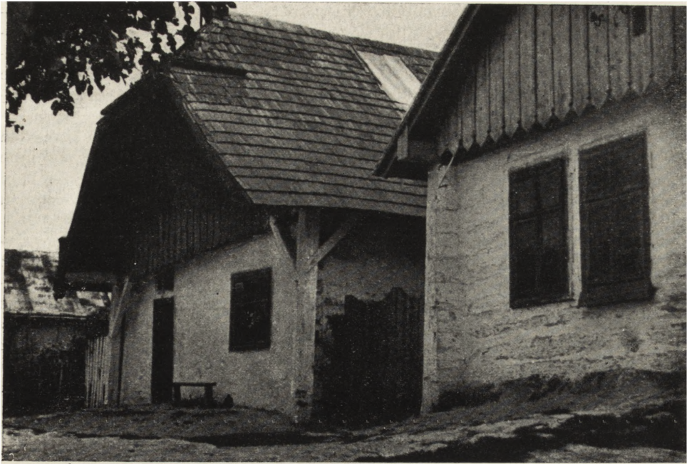
Ryc. 35. Kańczuga, pow. Przeworsk — dom przysłupowy typu miejskiego z II poł. XIX w., 1952.
