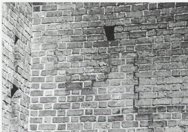
2. Mur wewnętrzny naprzeciwko ul. Podwale 15 — przykład zastosowania „czarnej” spoiny do zaznaczenia starych fragmentów murów. Fot. Agnieszka Jarmontowicz
