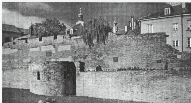
1. Mur zewnętrzny (niski z półbasztą) i mur wewnętrzny (wysoki), widok od strony południowej. Fot. Agnieszka Jarmontowicz
