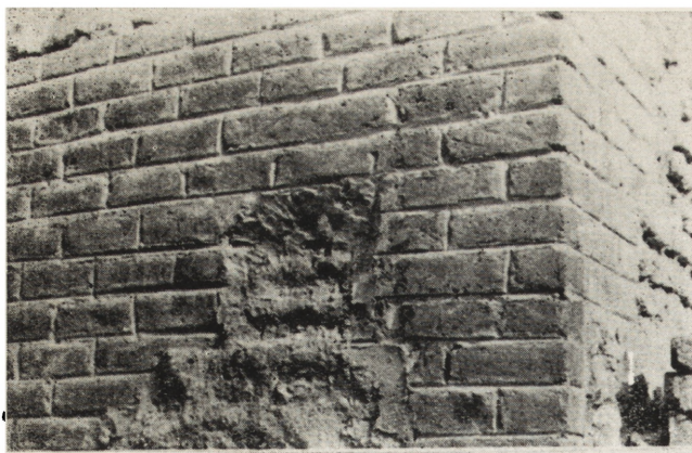
1. Aleksandria, łaźnie rzymskie. Narożnik uzupełniany wg metody próbnej (na wąską spoinę i bez nawiązania poziomów warstw cegły starego i nowego muru)
