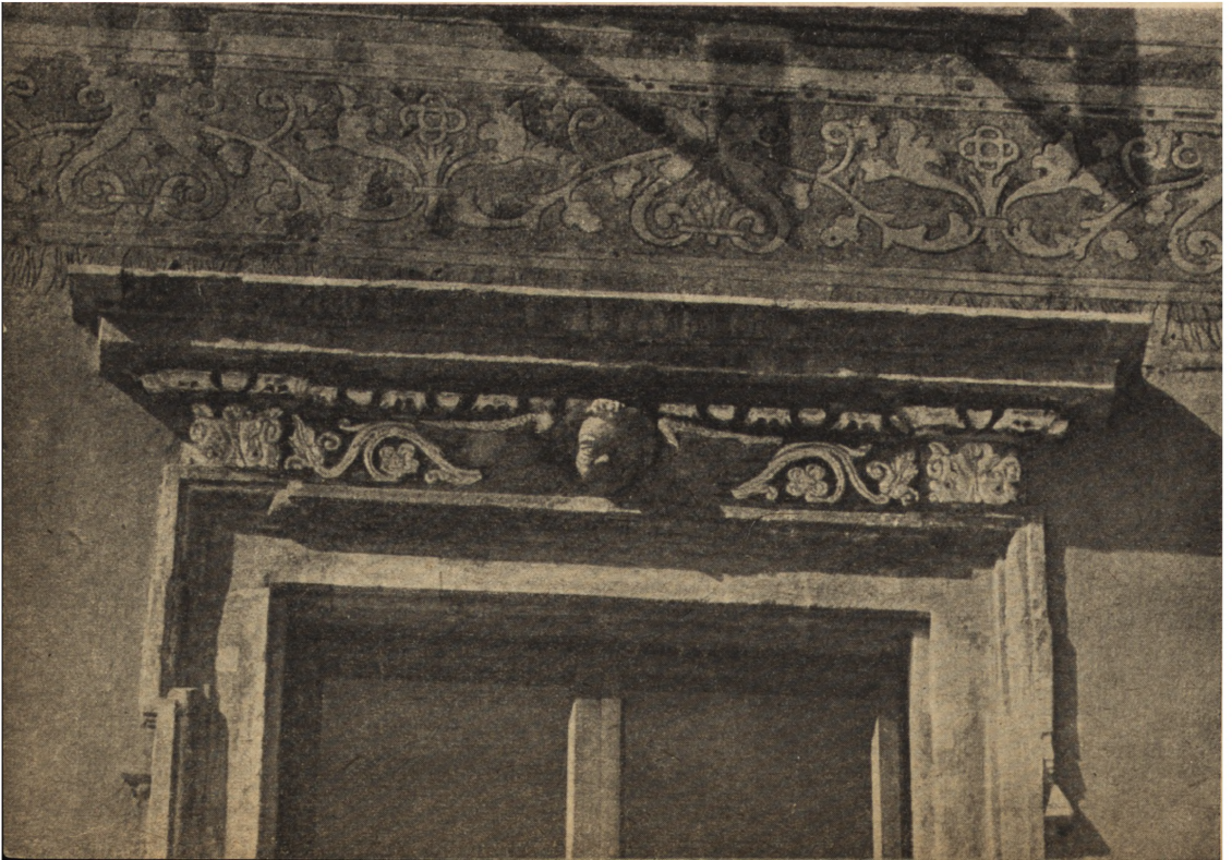
Ryc. 190. Renesansowy fryz sgraffitowy i dekoracja rzeźbiarska nadproża okiennego w tzw. kamienicy książąt Mazowieckich — Rynek St. Miasta nr 31.
