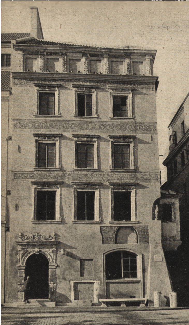
Ryc. 182. Kamienica ks. Mazowieckich, Rynek nr 31. Stan obecny.
