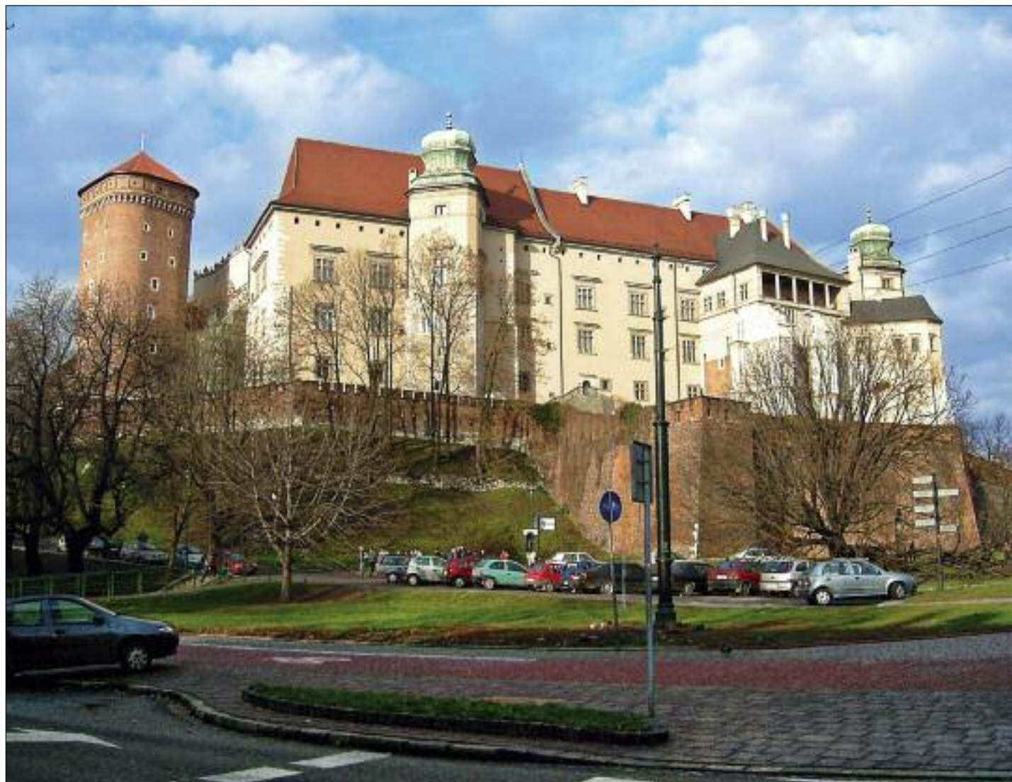
6. Elewacja wschodnia zamku z elementami kreacji konserwatorskiej Adolfa Szyszko-Bohusza (kompozycja górnej części Jordanki, loggia na wieży Duńskiej), stan obecny.
