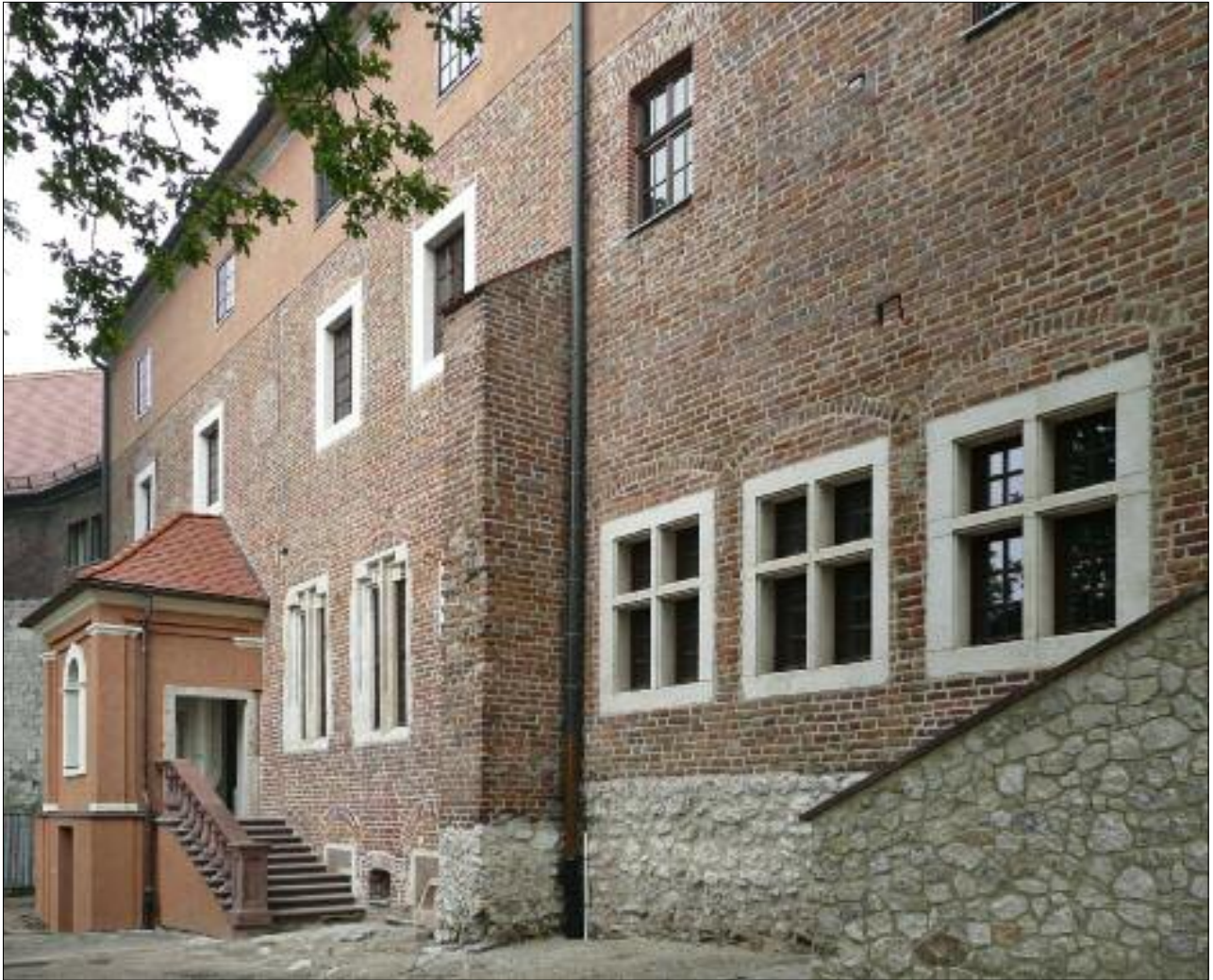
17. Południowo-wschodnia elewacja budynku nr 7, tj. zespołu trzech dawnych domów gotyckich, po rewaloryzacji przeprowadzonej w latach 2005-2009 wg projektu Wojciecha Koziola z zespołem.
