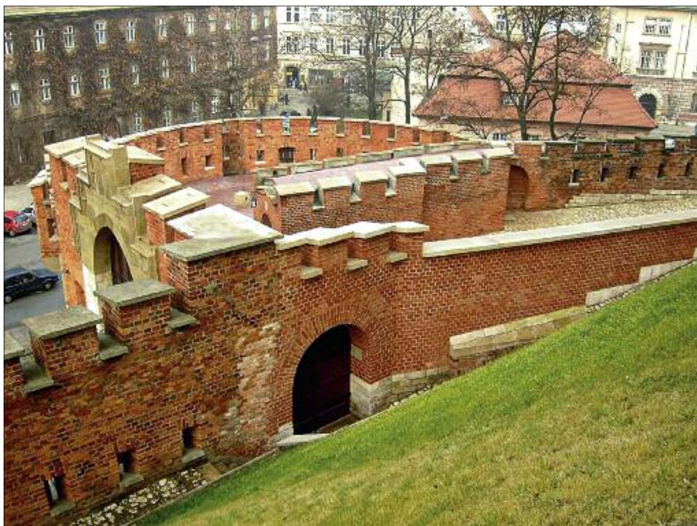
16. XIX-wieczne fortyfikacje austriackie w północno-wschodniej części wzgórza (bastion pod Kurzą Stopką wraz z bramą i przyległe mury obwodowe), stan po konserwacji przeprowadzonej w 2003 r. (proj. Piotr Stępień i Stanisław Karczmarczyk).
