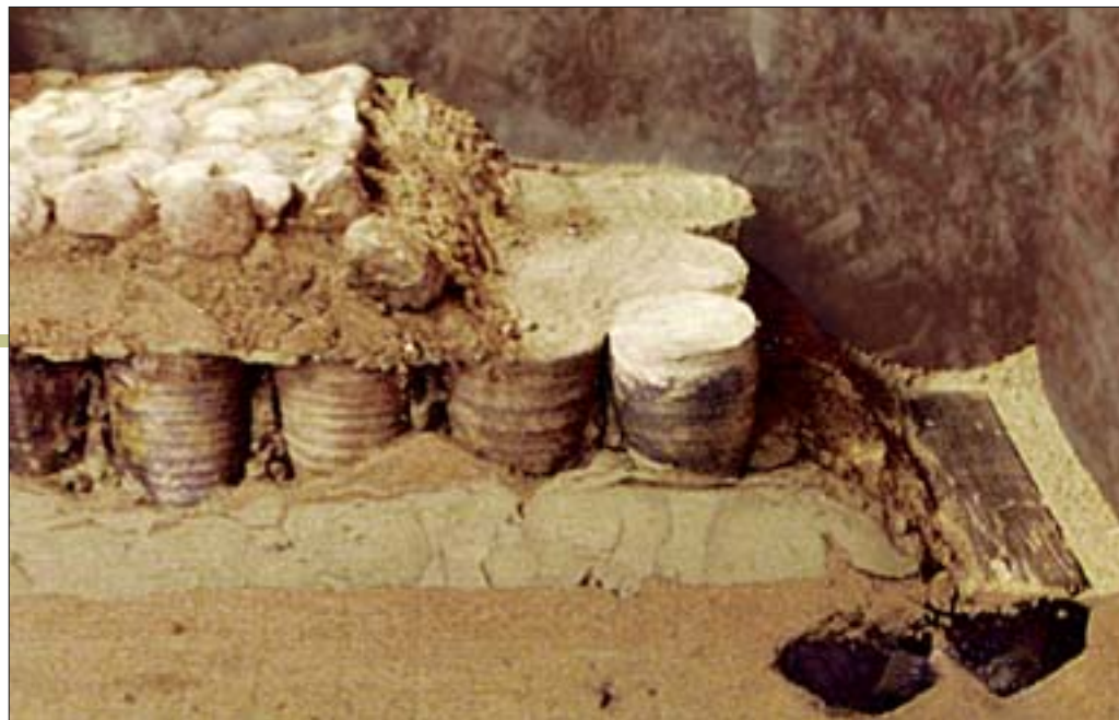
14. Stanowisko II, wykop 8b. Ekspozycja w salach wystawowych zamku w Nidzicy ukazująca sposób izolacji budynku od podłoża przy użyciu tzw. garnków „izolacyjnych”.
