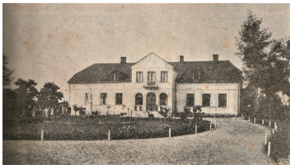
Ryc. 3. Dwór po remoncie i zaadaptowaniu na cele kultu, stan w 1912 r.
