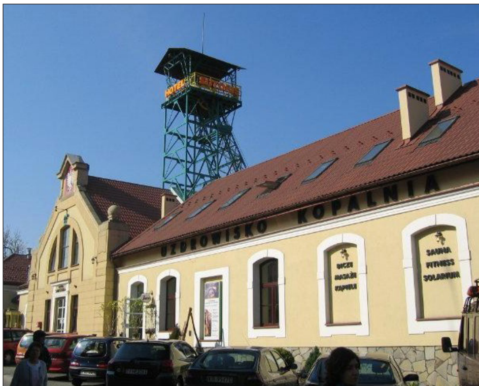
Fot. 15. Współczesny wygląd nadszybia trzynastowiecznego szybu Sutoris po generalnej przebudowie zakończonej w 1995 r. Obecnie służy jako rezerwowo oraz dla zjazdów kuracjuszy i gości hotelowych (fot. P. Wszolek)
