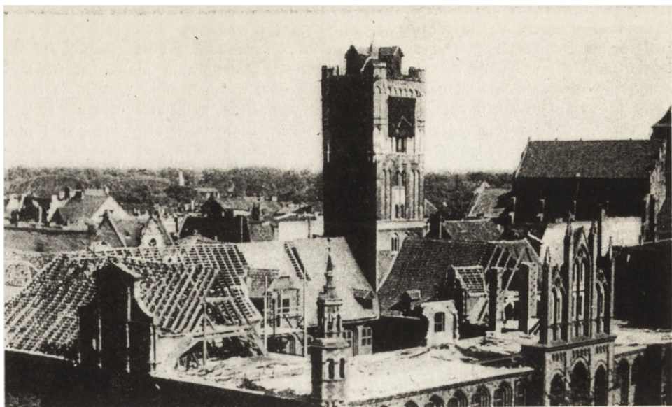
2. Toruń. Ratusz Staromiejski — stan w czasie remontu (Fot. A. Jarmułowicz)
