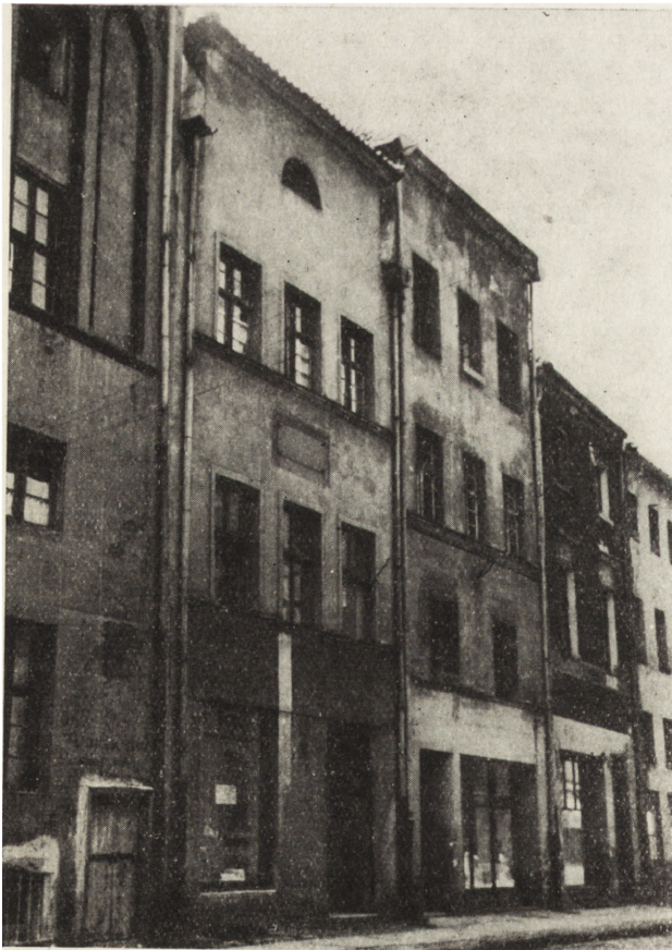
5. Toruń. Dom Kopernika, ul. Kopernika nr 17 — stan przed podjęciem prac konserwatorskich (Fot. P.K.Z. — Toruń)
