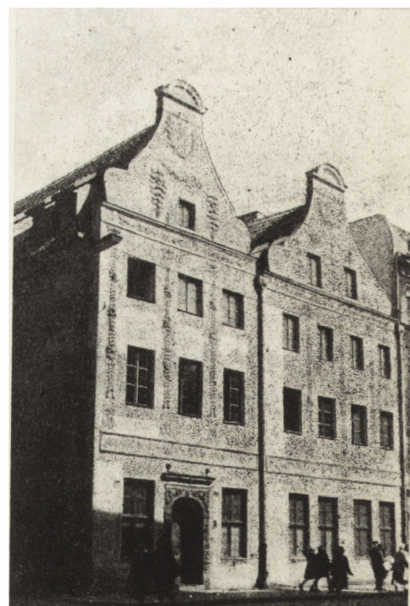
10. Toruń. Kamienice, ul. Dzierżyńskiego nr 28 — stan z 1964 r. po zakończeniu prac konserwatorskich (Fot. J. Gardzielewska)
