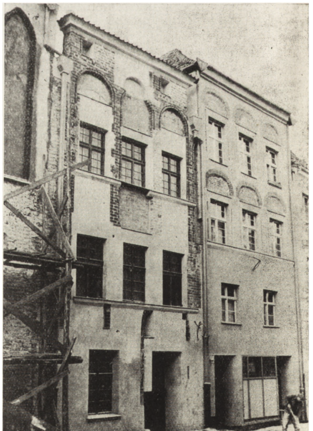
6. Toruń. Dom Kopernika, ul. Kopernika nr 17 — stan z 1960 r. po częściowym odsłonięciu gotyckich fragmentów elewacji (Fot. P. K. Z. — Toruń)
