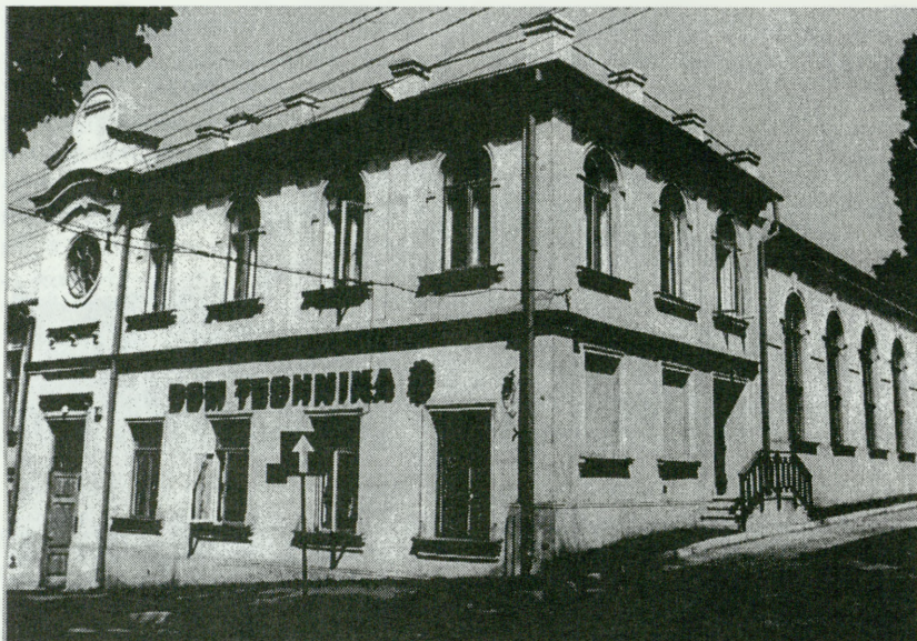
5. Chełm, mała synagoga. Widok od pd.-zach. Stan po konserwacji. Fot. P.Sygnowski 1987
