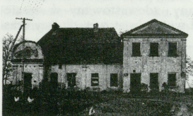
6. Dorohusk, pałac Suchodolskich. Widok od pd. Stan przed konserwacją. Fot. S. Rudnik 1983
