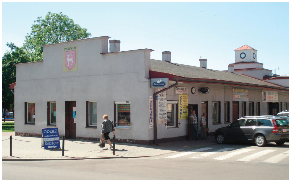
Fot. 3 i 4. Hala targowa w Parczewie – stan obecny. Fot. J. Żywicki 2013.
