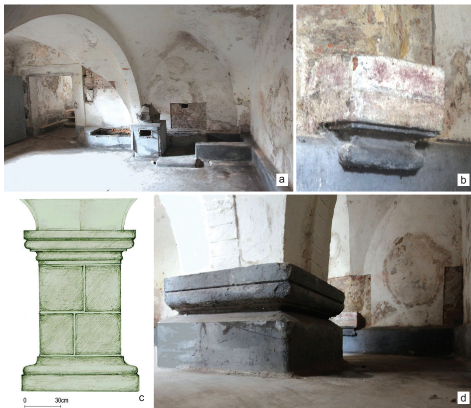
Il. 2. Piwnica z fragmentem dawnego cellarium trzebnickiego w 2015 r.: a – ściana zachodnia, b – wspornik, c – rekonstrukcja północnego lica filara, d – impost filara (oprac. E. Łużyniecka)
