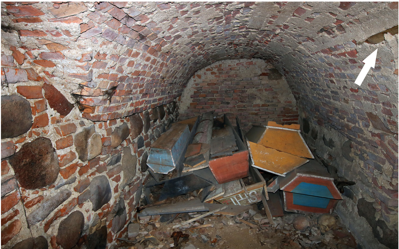
Ryc. 11. Widok na wnękę północną w krypcie w nawie zachodniej. Strzałką został zaznaczony fragment drewnianego szalowania krypty (fot. D. Grupa)
